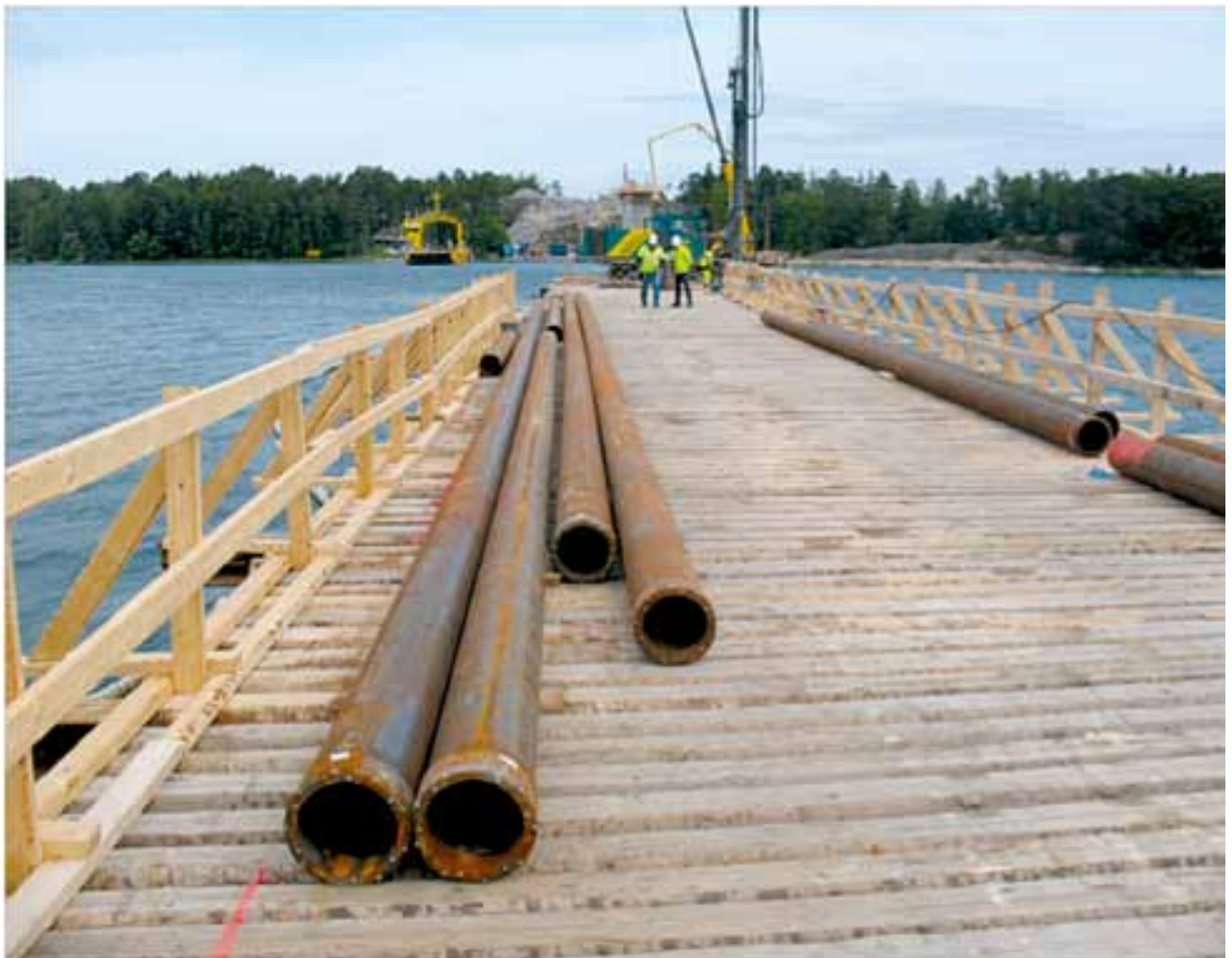
Kuva 2 . Teräksiset porapaalut työsillalla.
