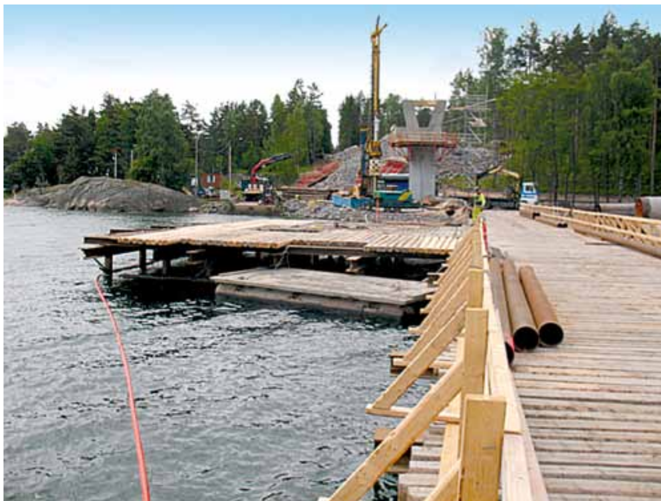
Kuva 7. Työsillan levike pelkkojen asennuksen jälkeen.
