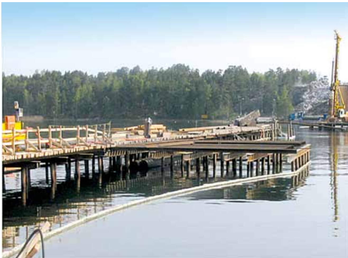
Kuva 6. Työsillan levike ennen pelkkojen asennusta.
