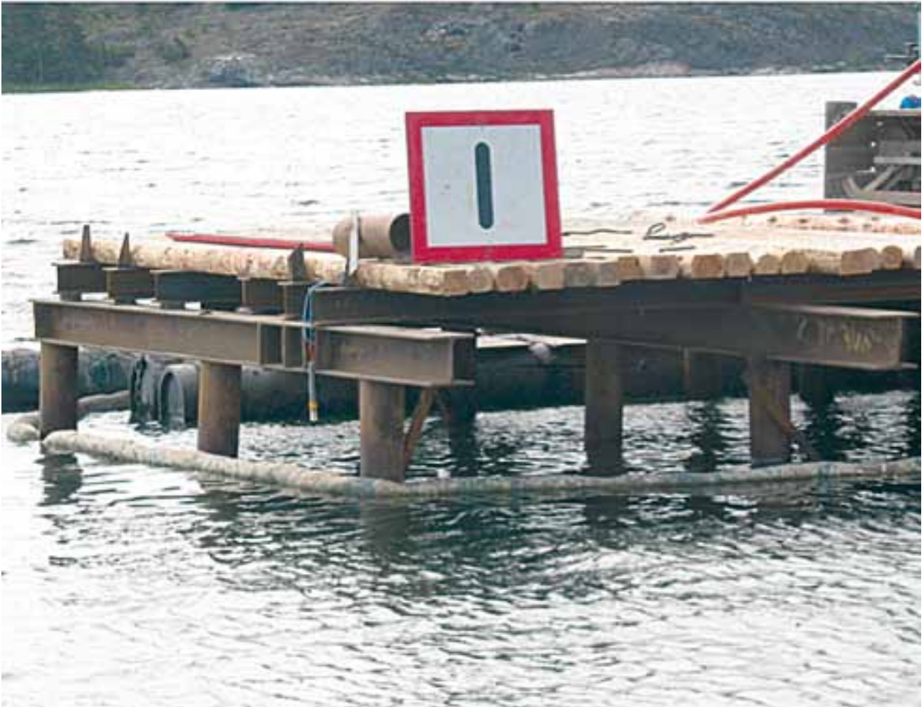
Kuva 4. Työsillan rakenne.
