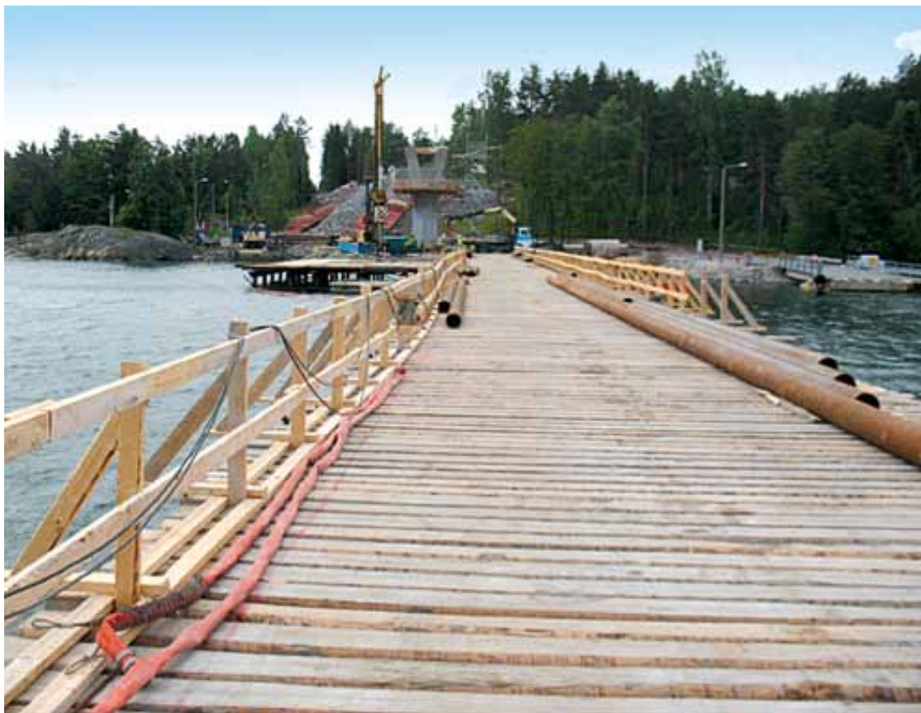
Kuva 1. Rakennettavan sillan viereen tehty työ- ja ajosilta.
