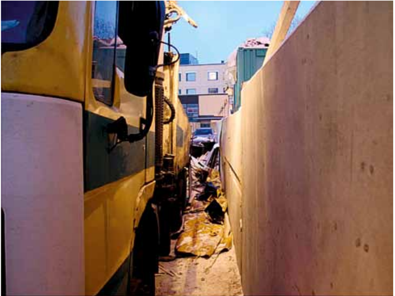
Kuva 4. Kuorma-auton ja betoniseinämän väliin jäi noin 70 cm leveä tila liikkumista varten.
