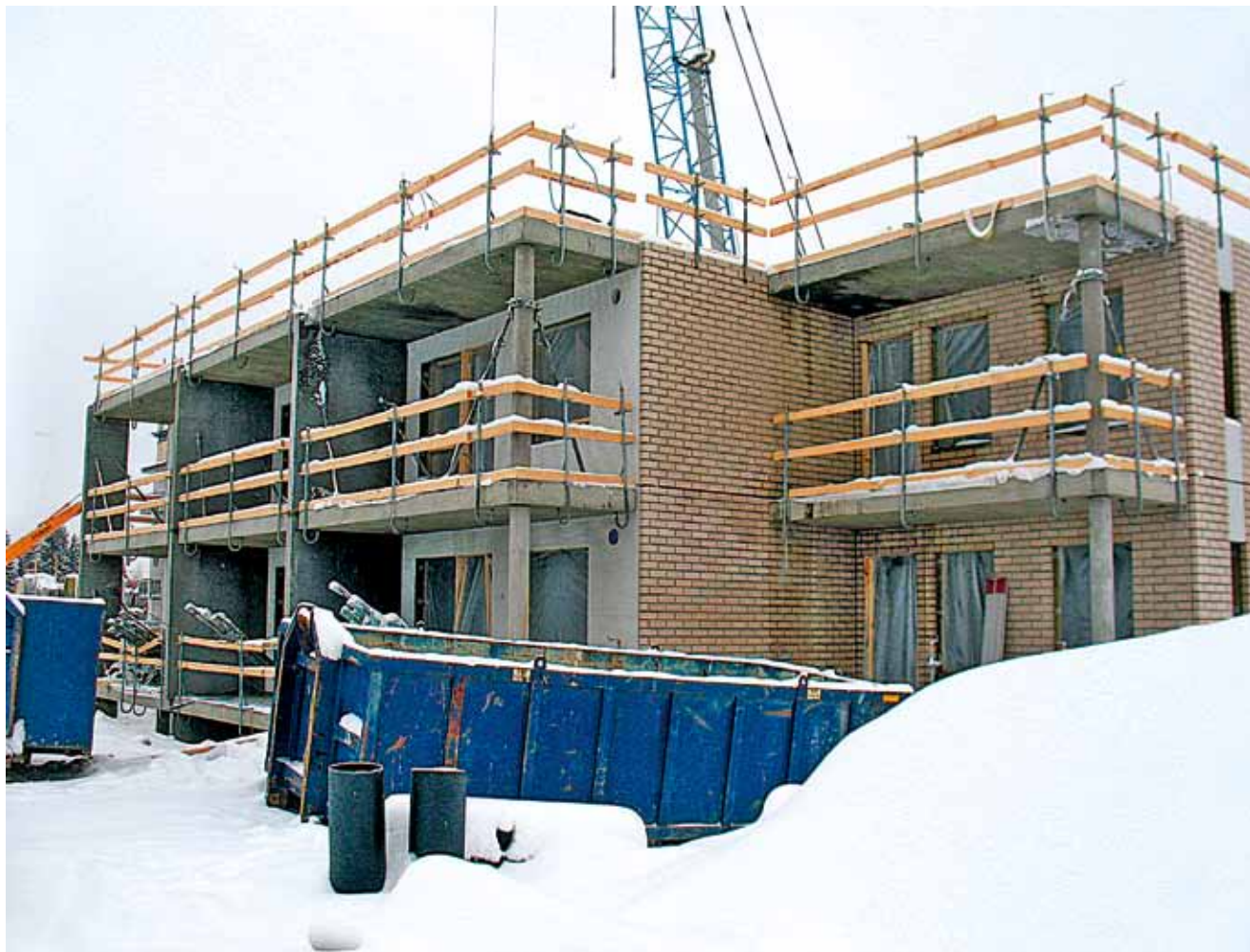
Kuva 14. Putoamissuojaussuunnitelman mukainen julkisivu.
