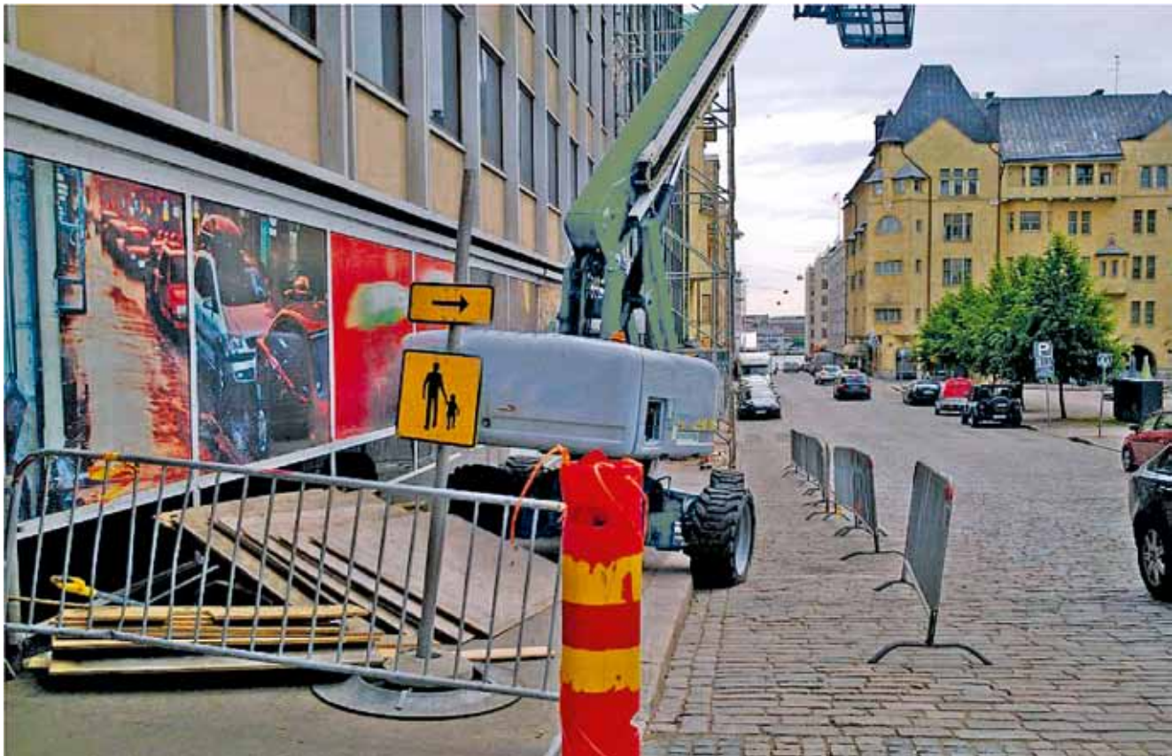
Kuva 11. Myös ympäristön viat ja puutteet on poistettava ennen töiden jatkumista.
