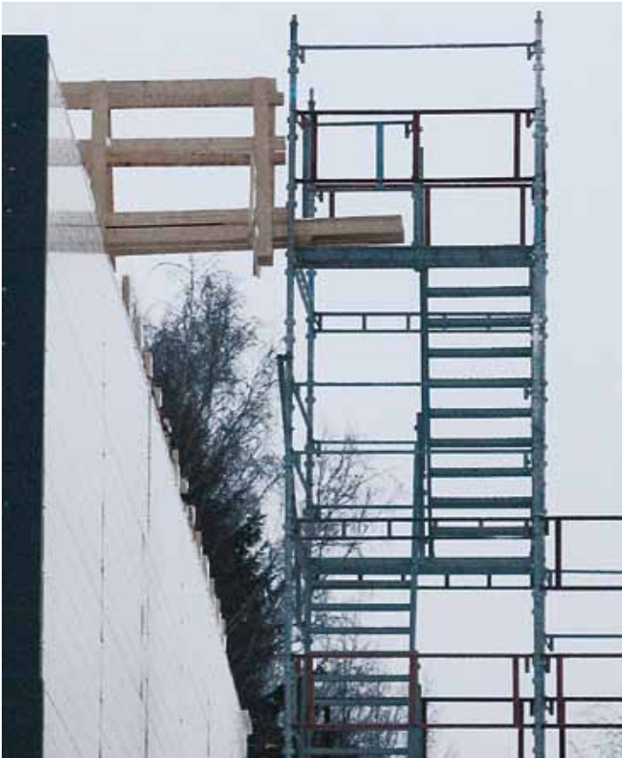
Kuva 10. Asianmukainen nousutie vesikatolle.
