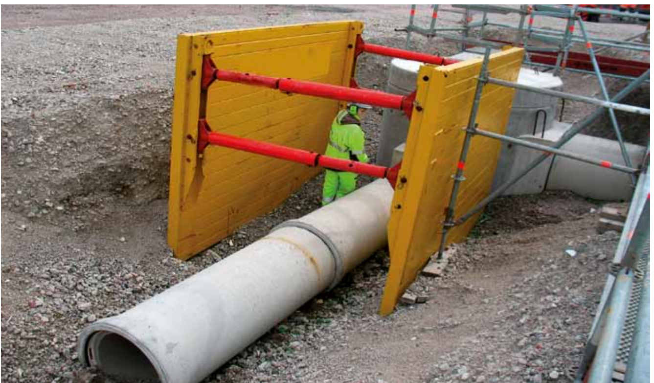
Kuva 8. Kaivantojen sortumat estetään kaivantotukielementein.
