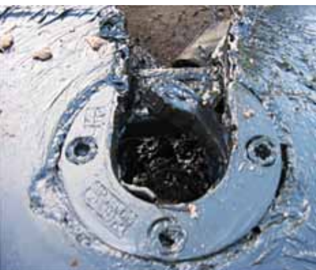
Kuva 4. Tapaturmassa vaurioitunut vetopöytä lukituslaitteineen.
