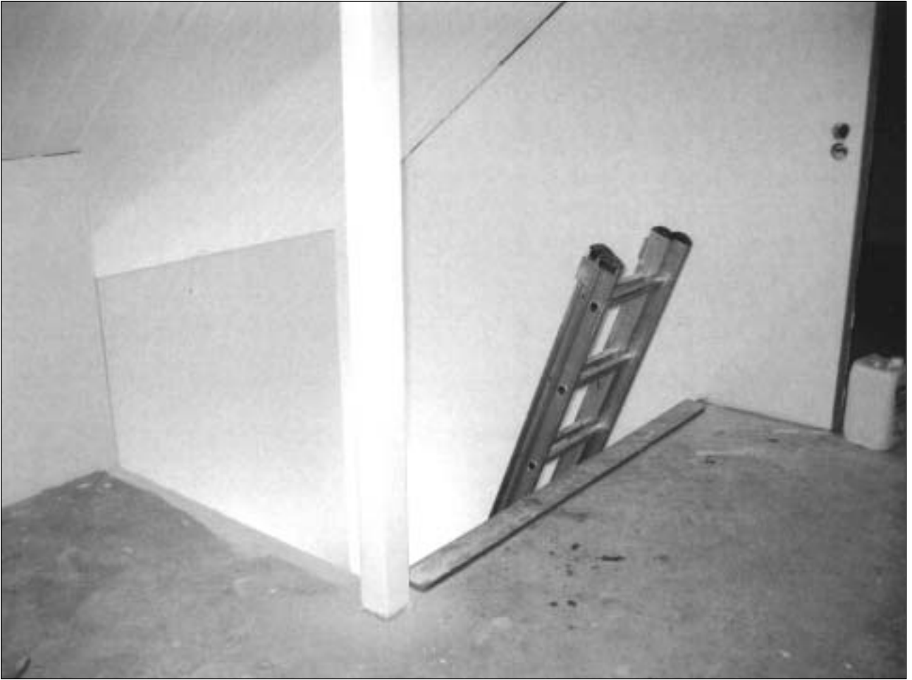
Kuva 3. Nojatikkaiden yläpää 2. kerroksessa.
