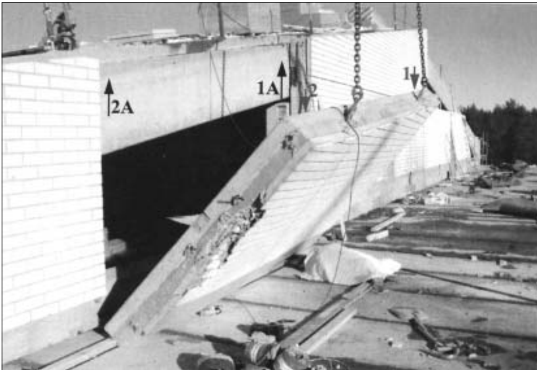
Kuva 3. Aamupäivällä asennettu seinäelementti, jolle oli tehty kaksi kiinnityshitsausta.
