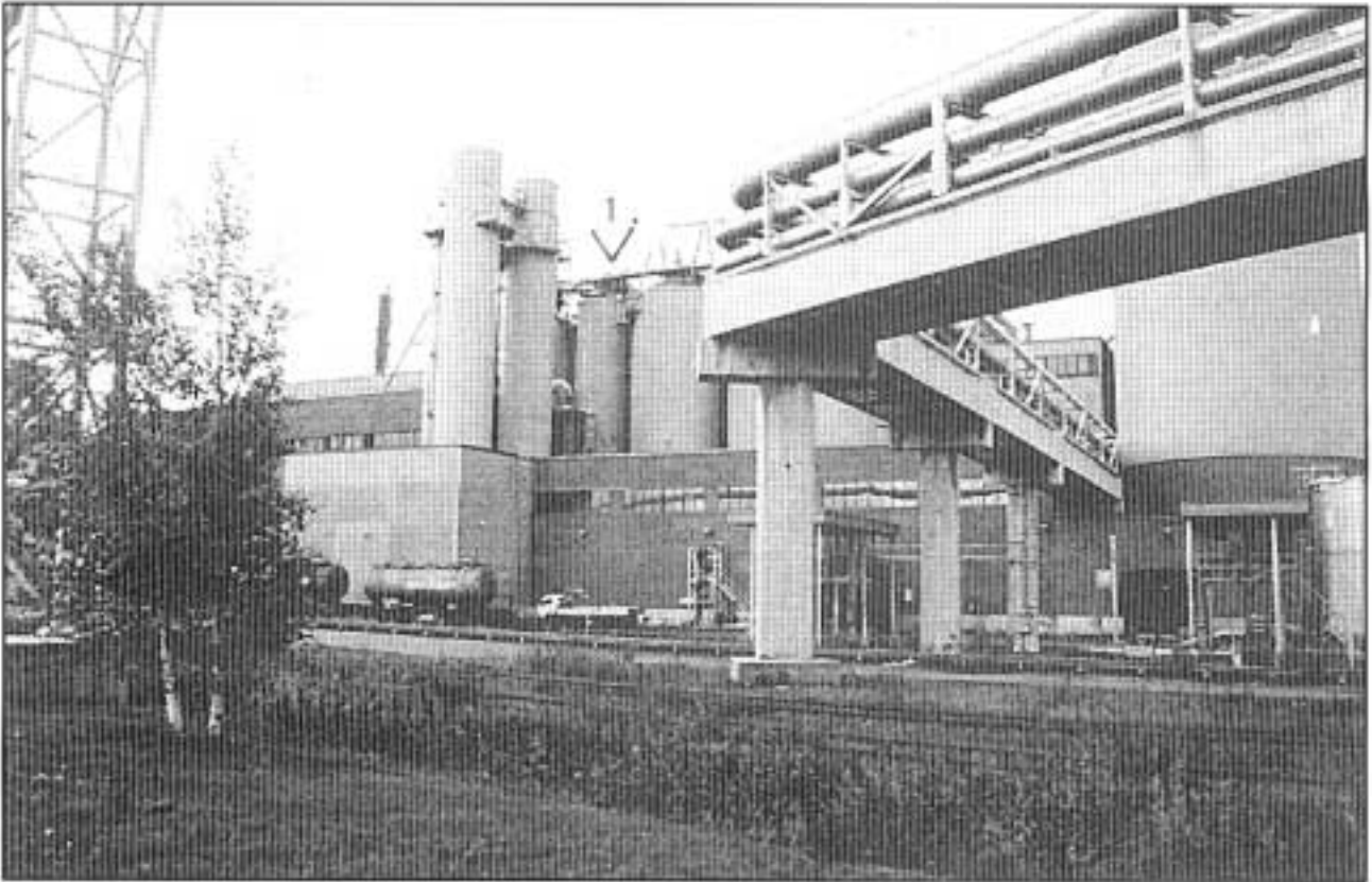
Kuva 1. Yleiskuva tapahtumapaikasta pohjoisen suunnasta kuvattuna. 1. Alkalitorni, jossa työtapaturma sattui.
