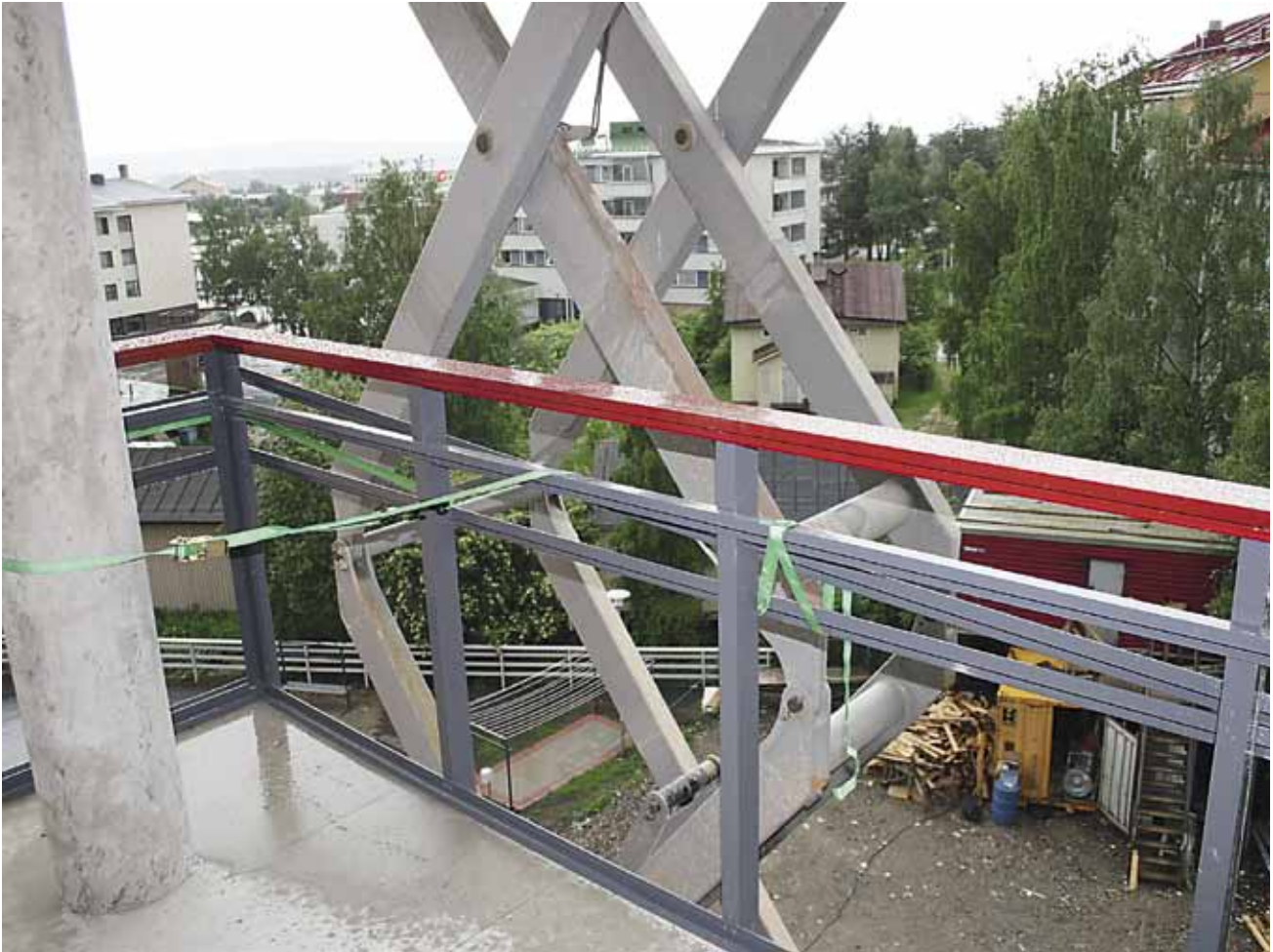
Kuva 2. Kaide-elementin väliaikainen kiinnitys (kaide-elementti on kuvaa varten nostettu takaisin paikalleen).
