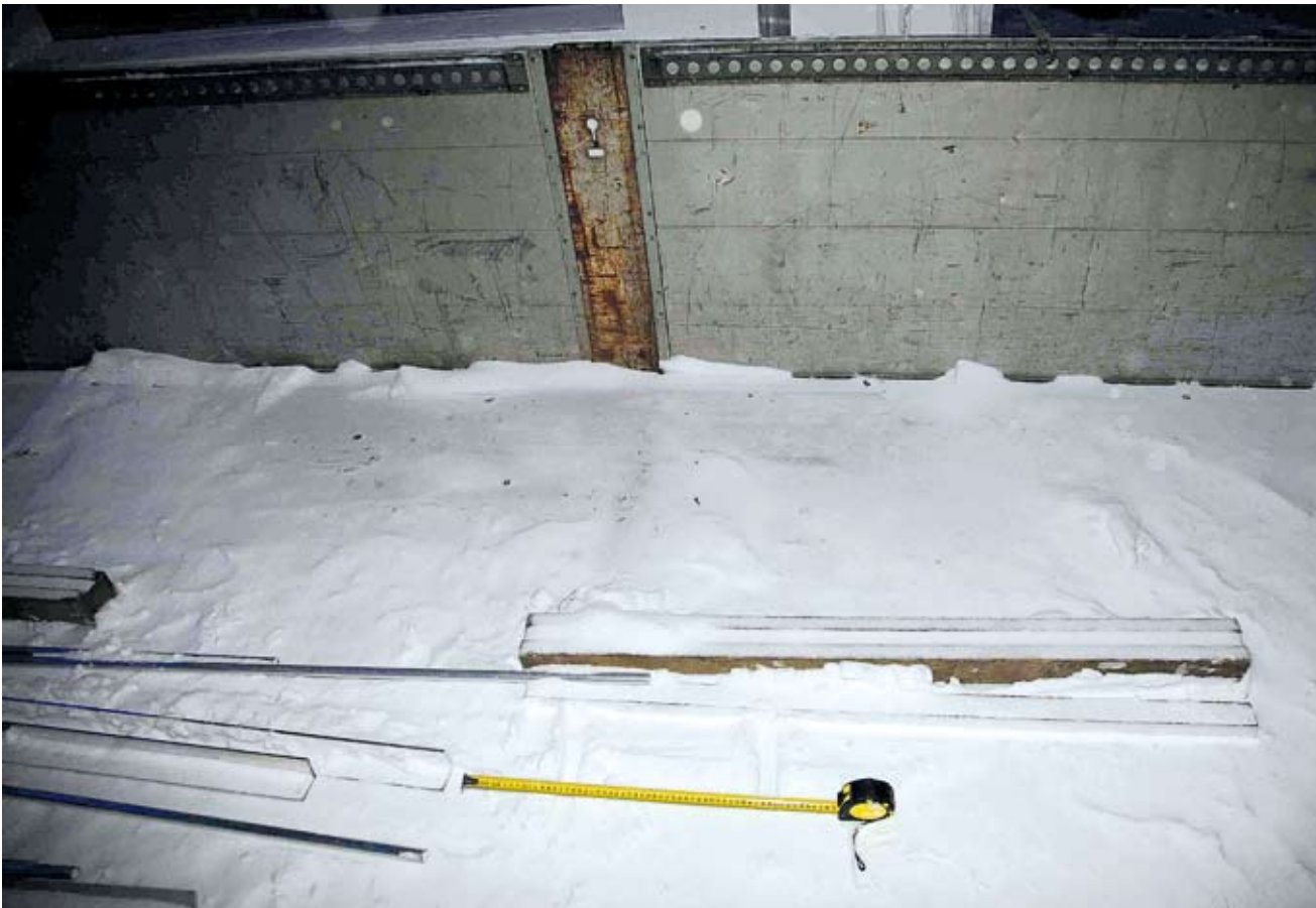
Kuva 3. Kuva lavalta. Mittanauha on tikkaiden jättämien jälkien kohdalla.
