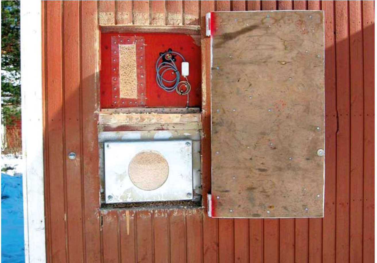
Kuva 5 teksti. Tapaturman jälkeen pelastustyön aikana tehtyyn aukkoon rakennettiin siilon huoltoluukku sekä ikkuna pelletin määrän tarkkailuun. Lisäksi siiloon asennettiin pintavahti (johdot).
