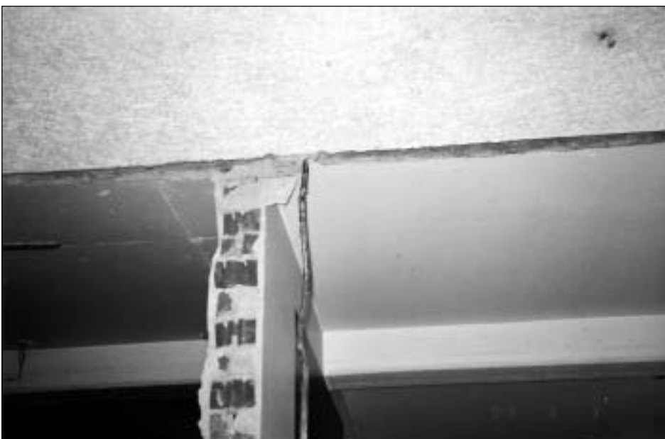
Kuvat 2 ja 3. Oviaukosta, palkin alta, purettua seinää.
