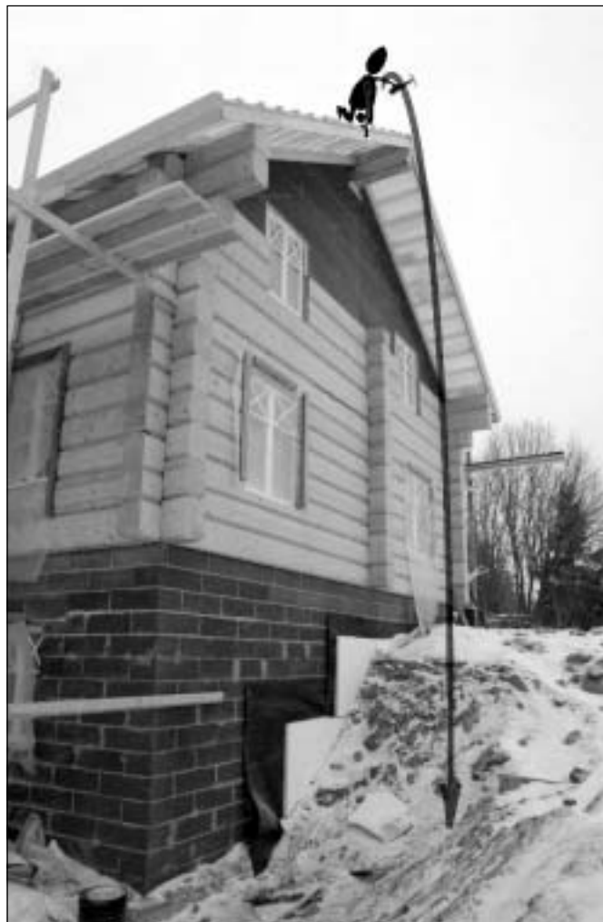
Kuva 2. NN:n putoamisreitti katolta.
