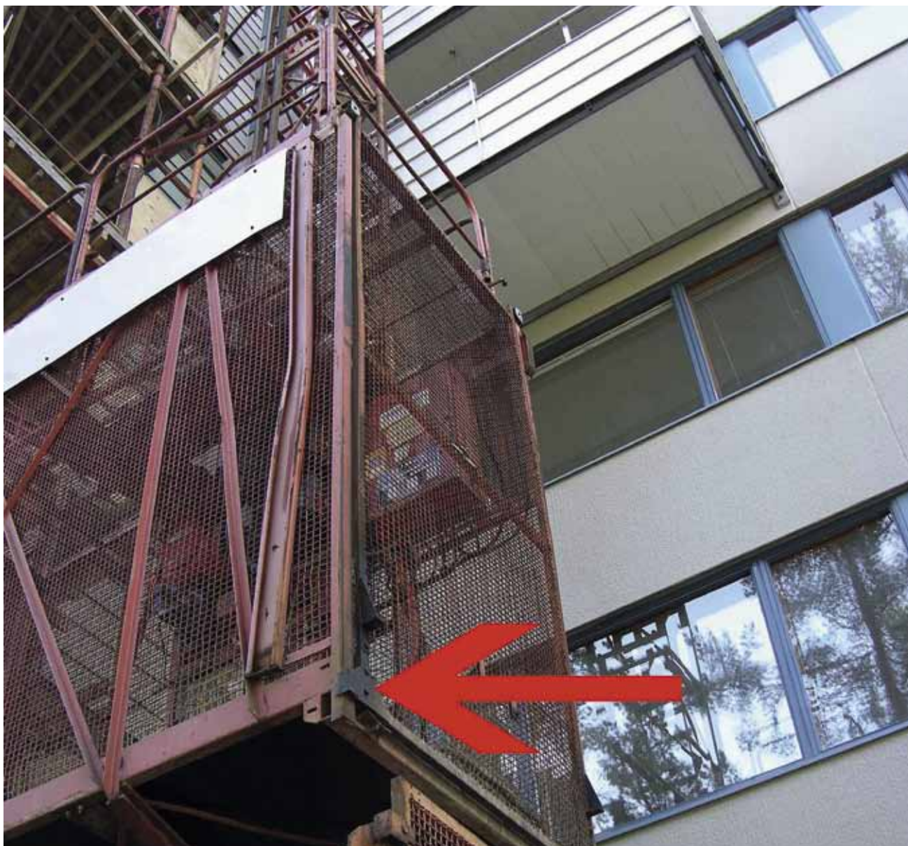
Kuva 1. Rakennushissi, jonka korin portti putosi. Kuva on otettu paljon tapaturmaa myöhemmin ja porttiin on jo tehty korjauksia. Nuoli osoittaa portin alareunan toista kynttä, joka estää portin sivusuuntaisen liikkeen (ts. pitää oven rullat vastinlistalla). Kuvan alareunassa näkyy osa maatasolla olevaa hissien häkkiä. Kuvasta on poistettu tunnisteet.
