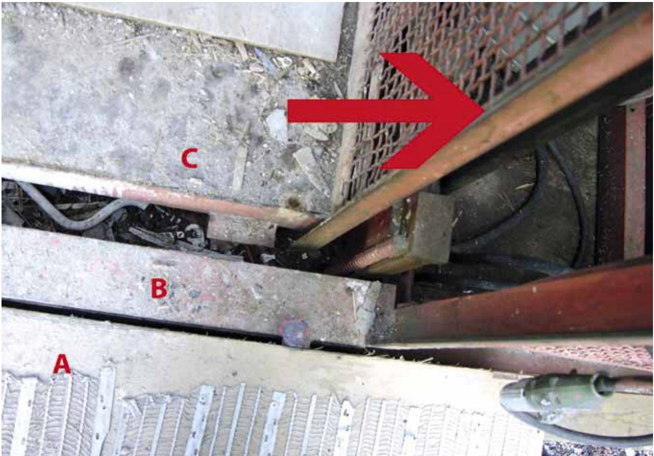
Kuva 2. Lähikuvassa maatasolla alaspäin kuvattuna lastaussilta hissille (A), hissien häkki (B) ja hissien kori (C). Nuoli osoittaa korin portin vastinlistan sisäsyryjää, jolla portin rulla liikkuu ja jonka ulkosyryjällä kynnet varmistavat. Korin alareunassa (kuvassa B:n ja C:n välissä oikealla) näkyy hissien portin alareunan pysäytinlippa ("oven alastoppari").
