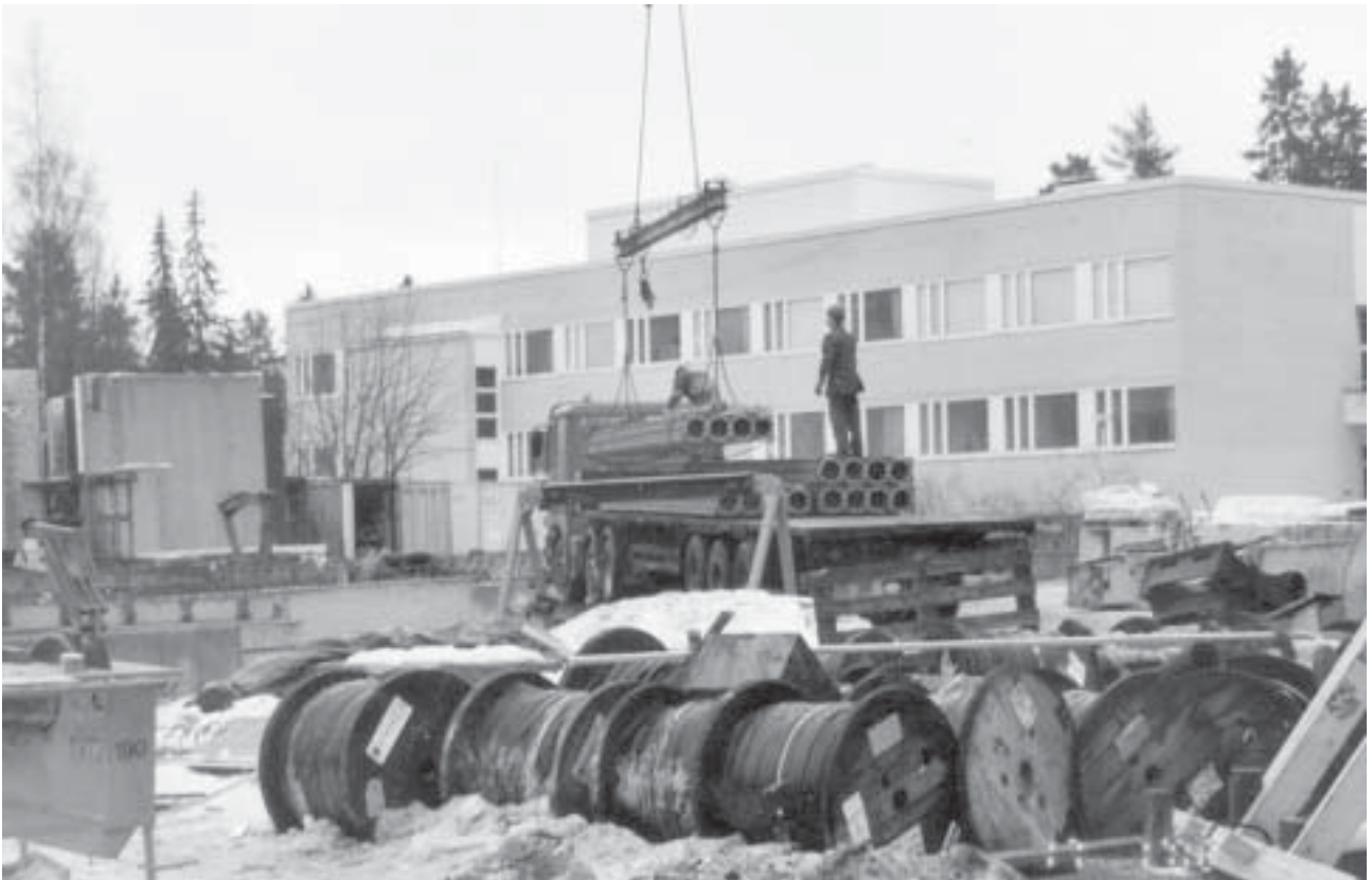
Kuva 1. Ontelolaatat nostettiin suoraan kuorma-autosta asennuskohteeseen.
