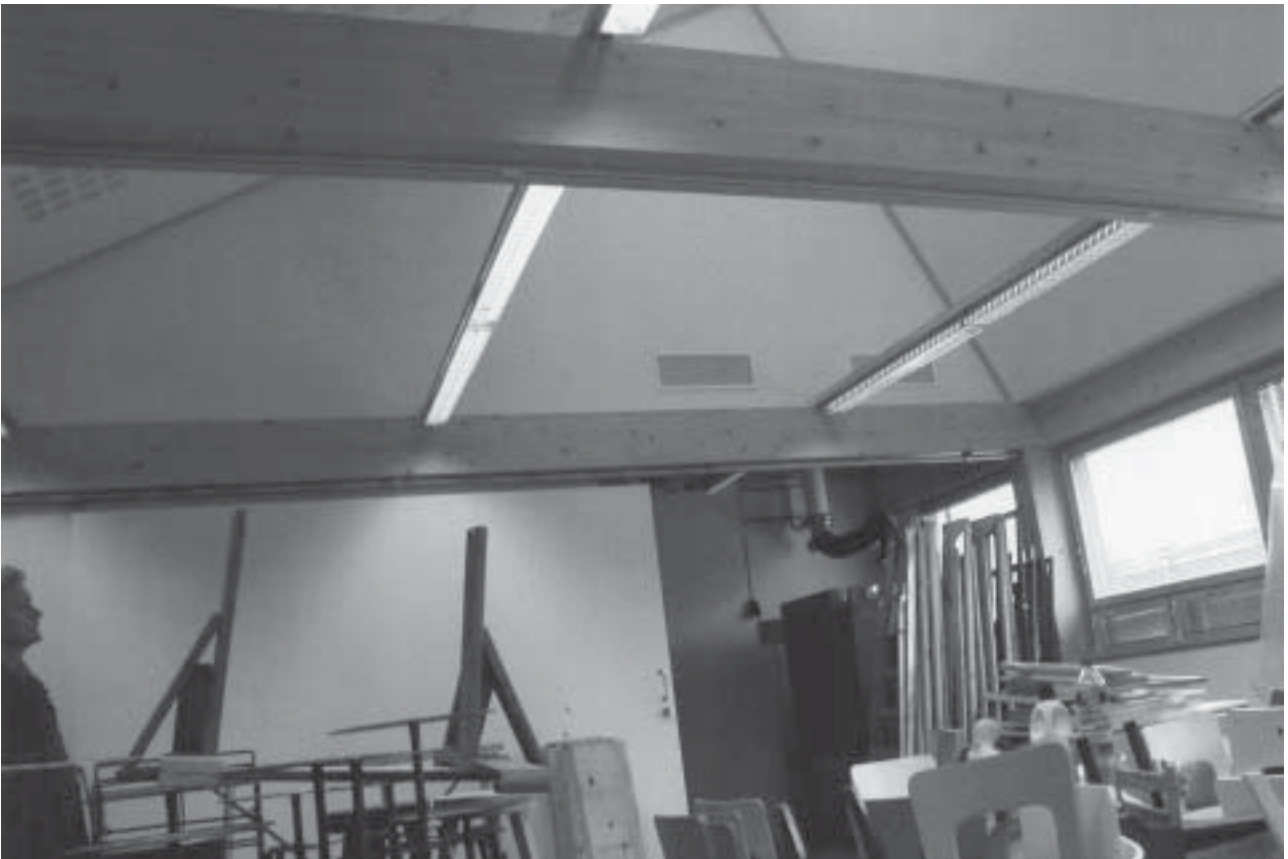
Kuva 1. Päätykolmio, palkit, joille työtaso tehtiin.
