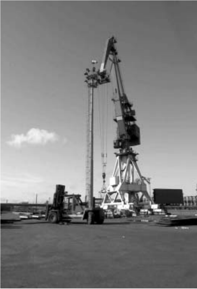
Kuva 1. Yleiskuva satama-alueesta. Taustalla purkutyössä käytetty nosturi. Edessä oleva trukki on sillä kohdalla, johon se oli pysäytetty tapaturman jälkeen.
