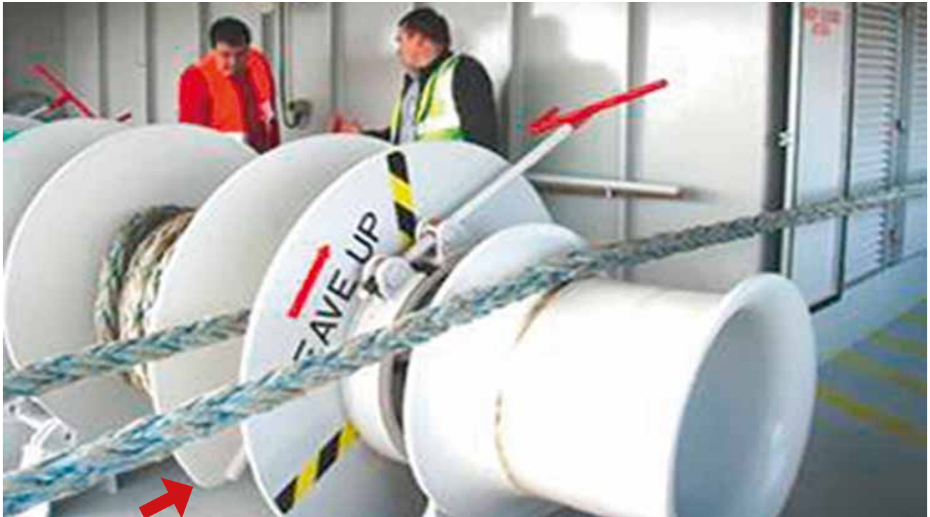
Kuva 4. Tapaturman ja vinssin korjaustöiden jälkeen vinssin työ- ja varastorumpujen välissä olevan metallilevyn reuna ei ole enää terävä vaan selvästi tasainen (nuoli), jolloin köyden poikkileikkautumisvaara on eliminoitu.
