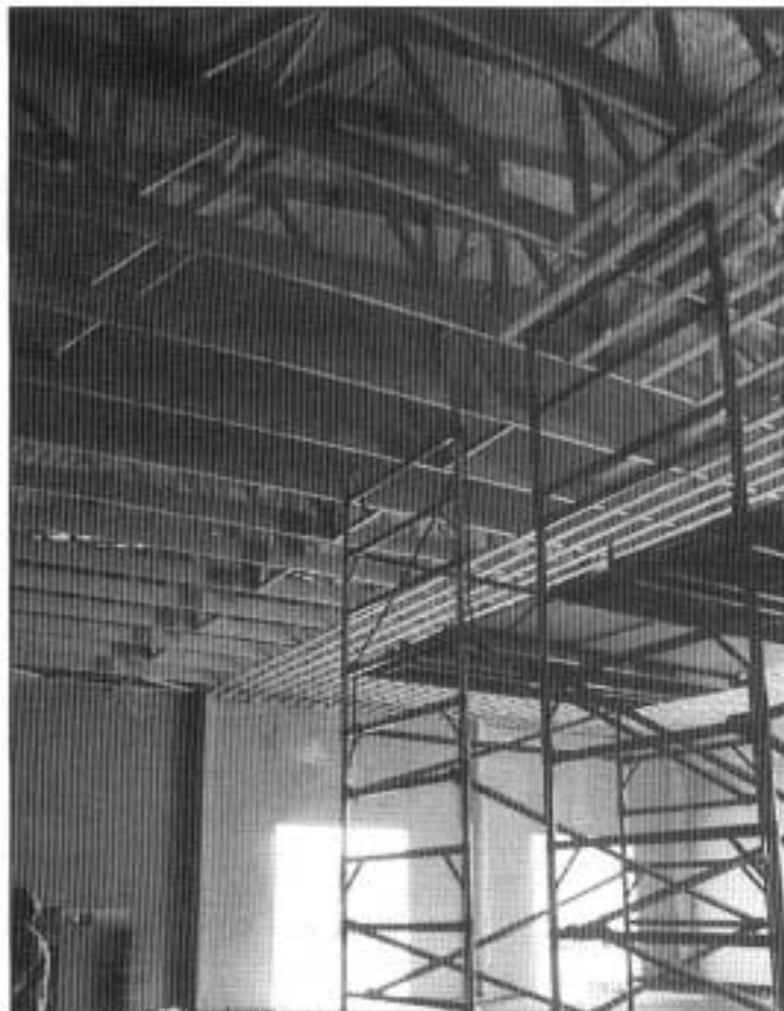
Kuva 2. Siirrettävät telineet, kattotuolit.
