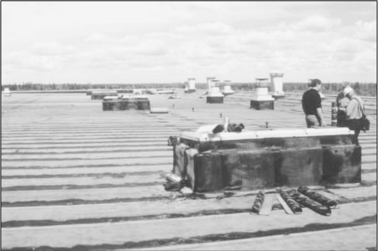
Kuva 1. Yleiskuva katolta, jossa näkyy neljä samanlaista savunpoistolaatikkoa.
