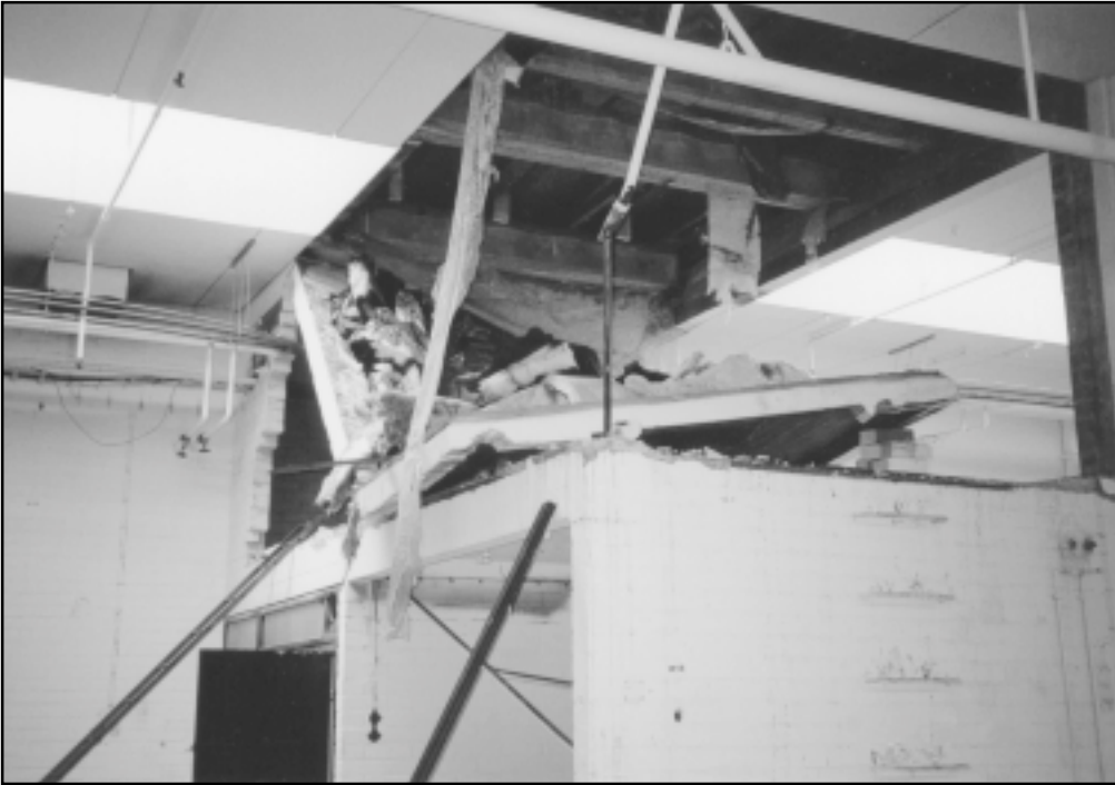
Kuva 1. Varastotilan seinät oli muurattu tiilestä ja niihin tukeutui teräsbetoninen kattolaatta, joka painoi noin viisi tonnia.
