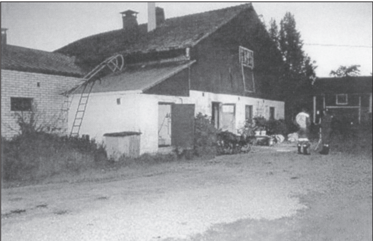
Kuva 1. Vuonna 1995 valmistunutta navetan uutta osaa näkyy kuvassa (tiiliseinä vasemmalla). Kiinteistön sähköpääkeskus sijaitsee talon ullakkotiloissa, joista johtaa pihapiirin yli kuvassa esiintyvä kaapeli navetan ylisille jakokeskukseen. Sähköpääkeskuksen kaikki sulakkeet tapahtuman jälkeen ehjät.
