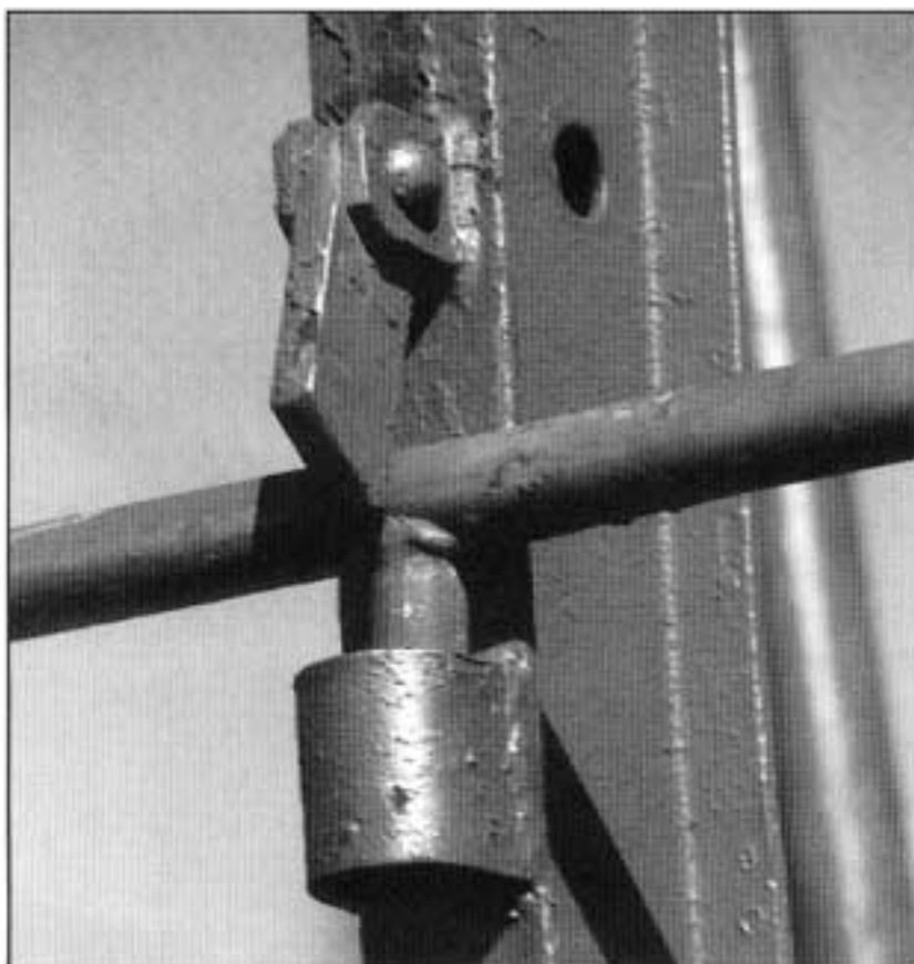
Kuva 3. Käsikaiteen tappi nousee kiinnitysholkista lukitusosalvan heilahtaessa eteenpäin.
