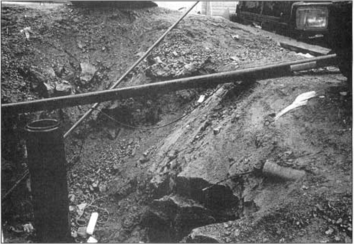
Kuva 3. Kuva samalta kohdalta laajennettuna näkymällä kaivannon pohjalle.
