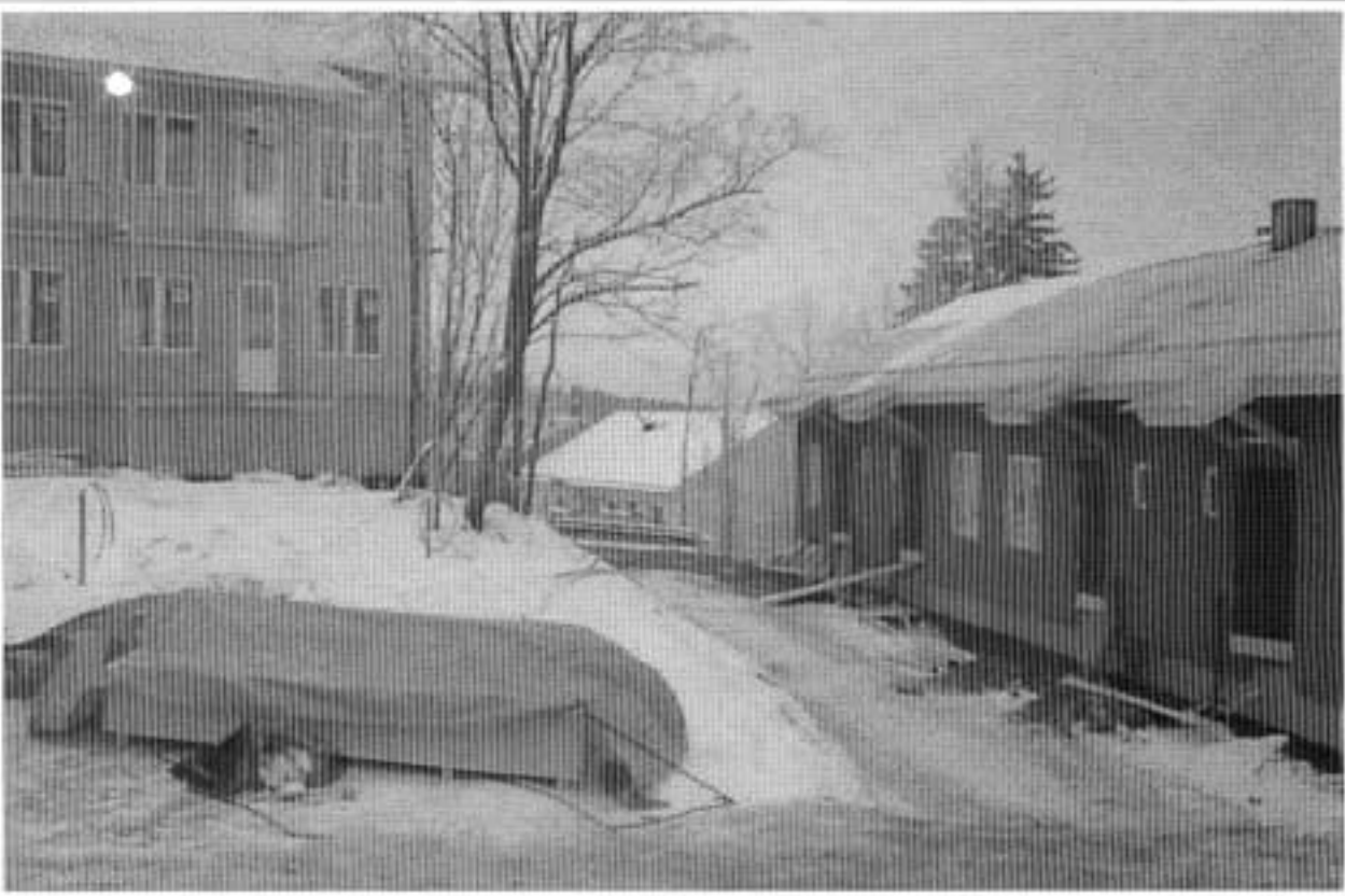
Kuva 2. Yleiskuva rakennustyömaasta. Onnettomuus sattui oikealla näkyvässä rakennuksessa. Vasemman puoleisen rakennuksen katon reunassa näkyy onnettomuuspaikkaa lähinnä ollut yleisvalaisin.
