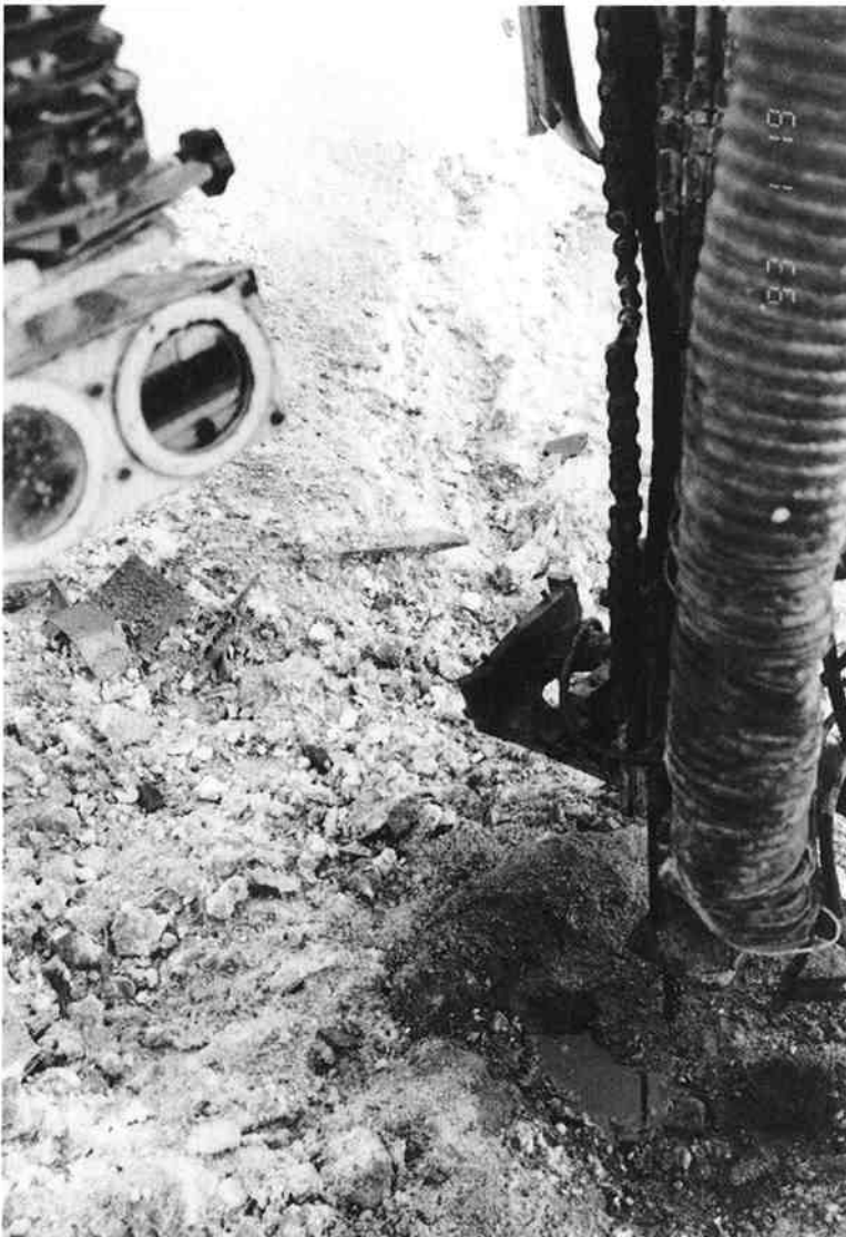
Kuva 4. Porareikäkentästä 1,5 m päästä löytynyt syvennys, johon ilmeisesti oli isketty poraa kalliota vasten.
