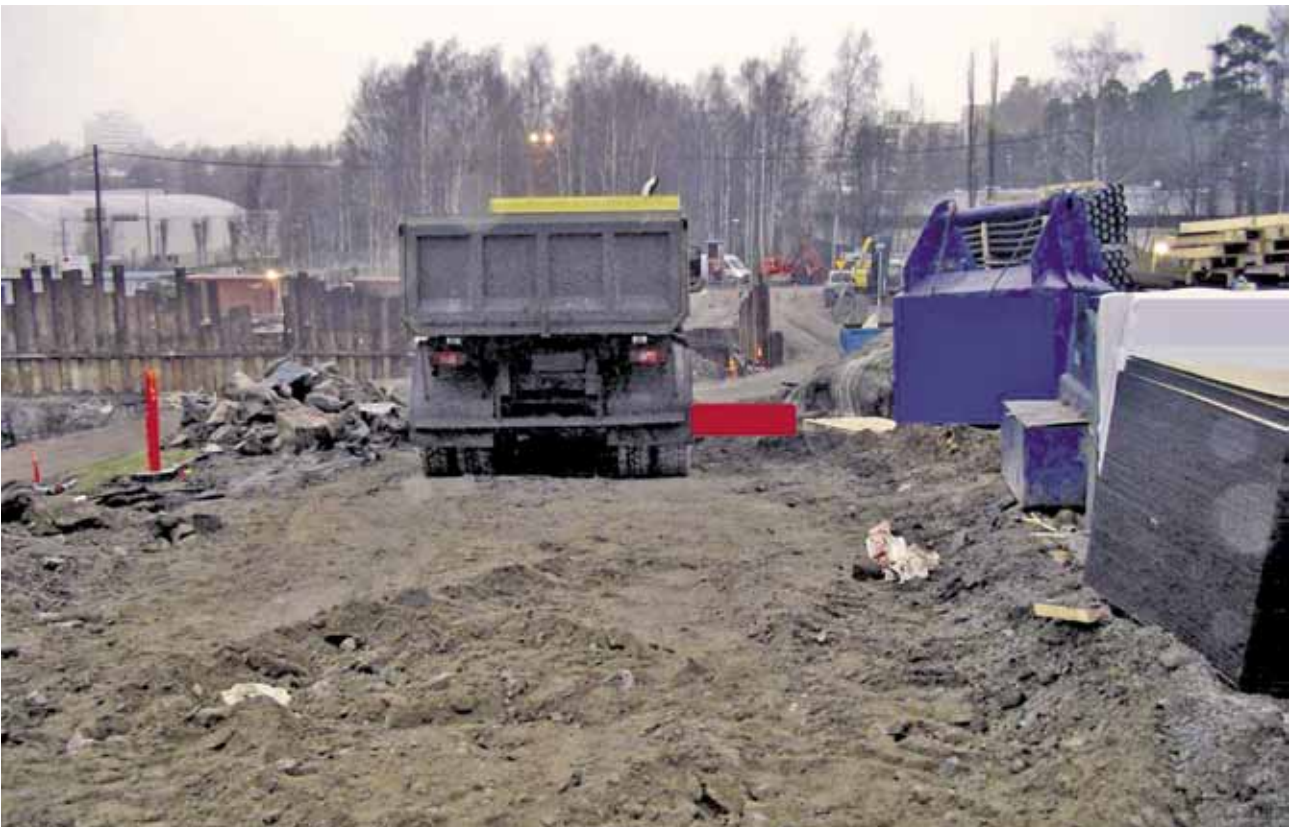
Kuva 2. Näkymä kaivinkoneen suunnasta. Punainen laatikko kuvaa paikkaa, johon NN jäi tapaturman jälkeen. Kuvasta on poistettu henkilöt.
