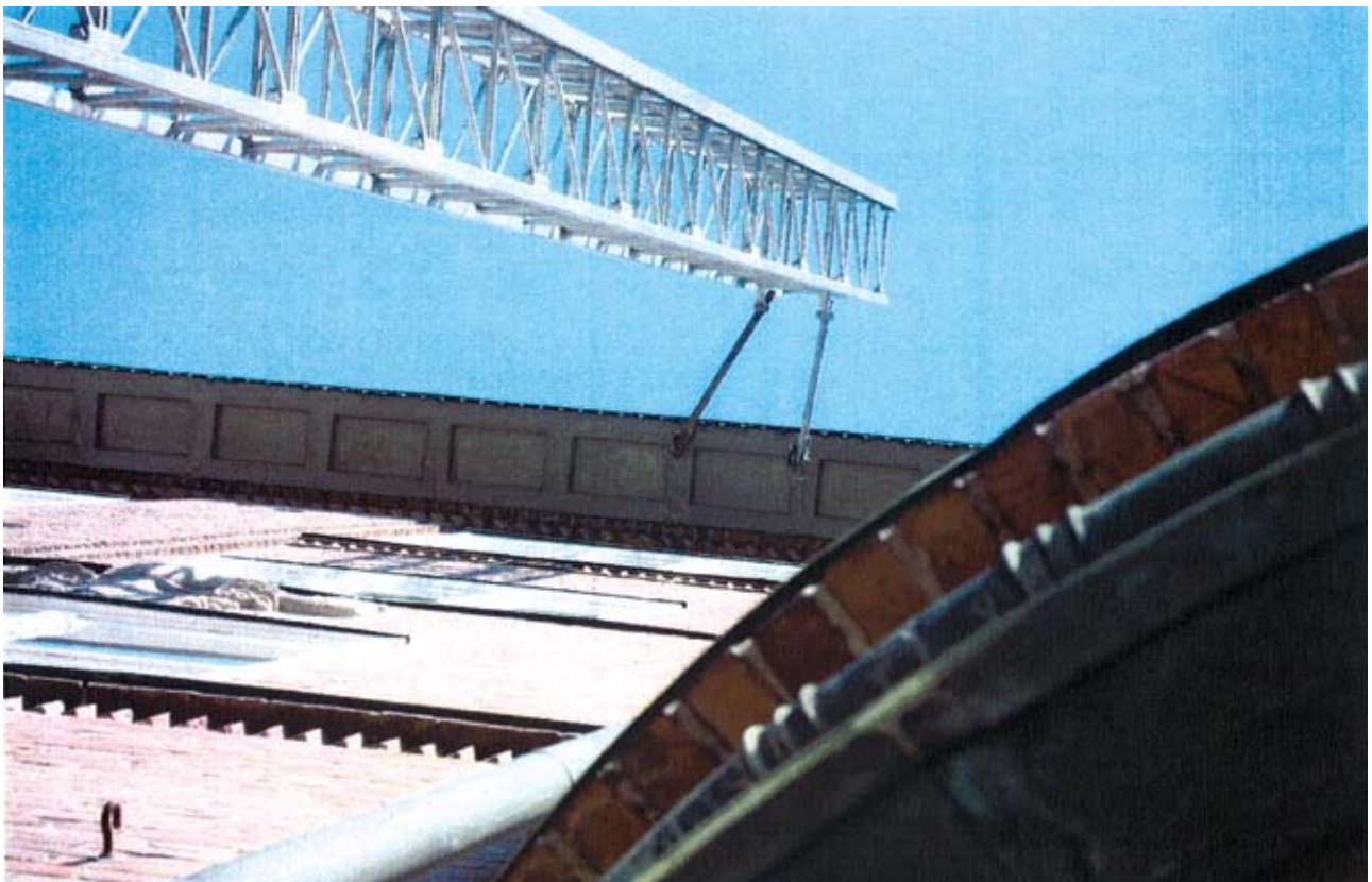
Kuva 3. Kuvassa masto, rakennus ja harustuskohta.
