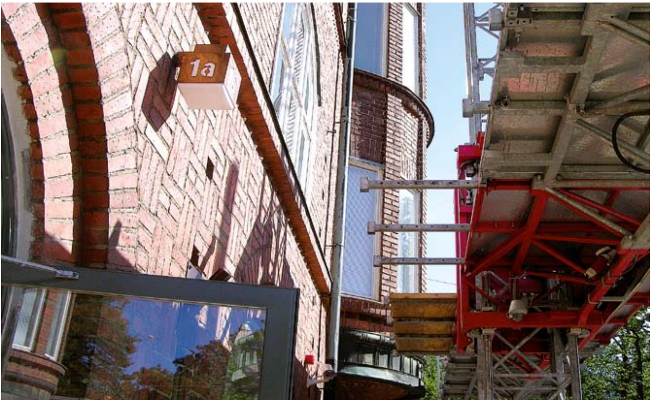
Kuva 1. Mastotyölavan työtaso, jossa näkyvät ulosvedetyt teleskooppiputket. Pystytysvaiheessa teleskooppiputkien päällä oli työtason levennyksenä vanerilevy. Kuvassa näkyy myös pystytysvaiheen aikainen, rakennuksen muodosta aiheutuva, mastotyölavan ja seinän välin jäävä aukko (n. 80 cm).
