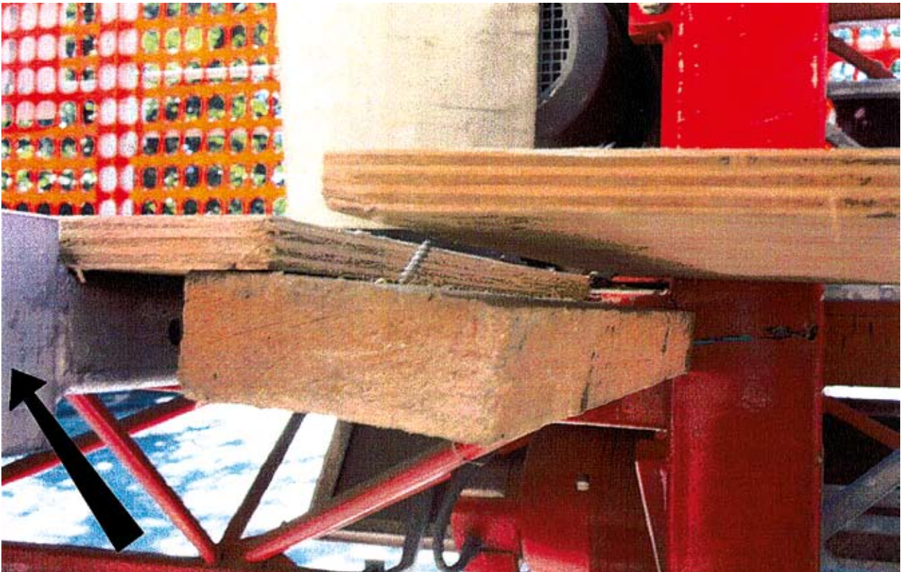
Kuva 2. Lavastettu työtason tuenta. Mastotyöalavan valmistaja edellyttää, että teleskooppilevikkeissä käytettävät levyt ovat vähintään 22 mm paksuista vesivaneria ja että ne kiinnitetään alla oleviin teleskooppiputkiin ruuveilla, muttereilla ja kiinnityslevyillä (teleskooppiputki merkitty kuvaan nuolella). Ei ole täysin varmaa, oliko pudonnut levy kiinnitetty kuvassa näkyvällä ruuvilla toiseen levyyn tai lankunpätkään vai olivatko levyt päistään vain päällekkäin.
