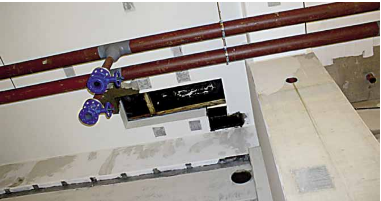
Kuva 2. NN putosi katossa keskellä olevasta aukosta 8 metrin matkan, jonka päälle oli asetettu vesivanerilevy.
