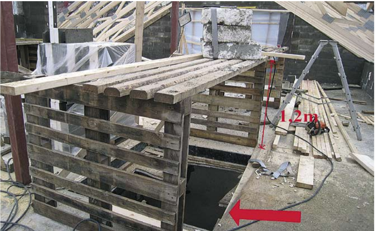
Kuva 4. Yleiskuva toisen kerroksen kulkuaukosta. Nuoli osoittaa kulkureittiä nojatikkaille.
