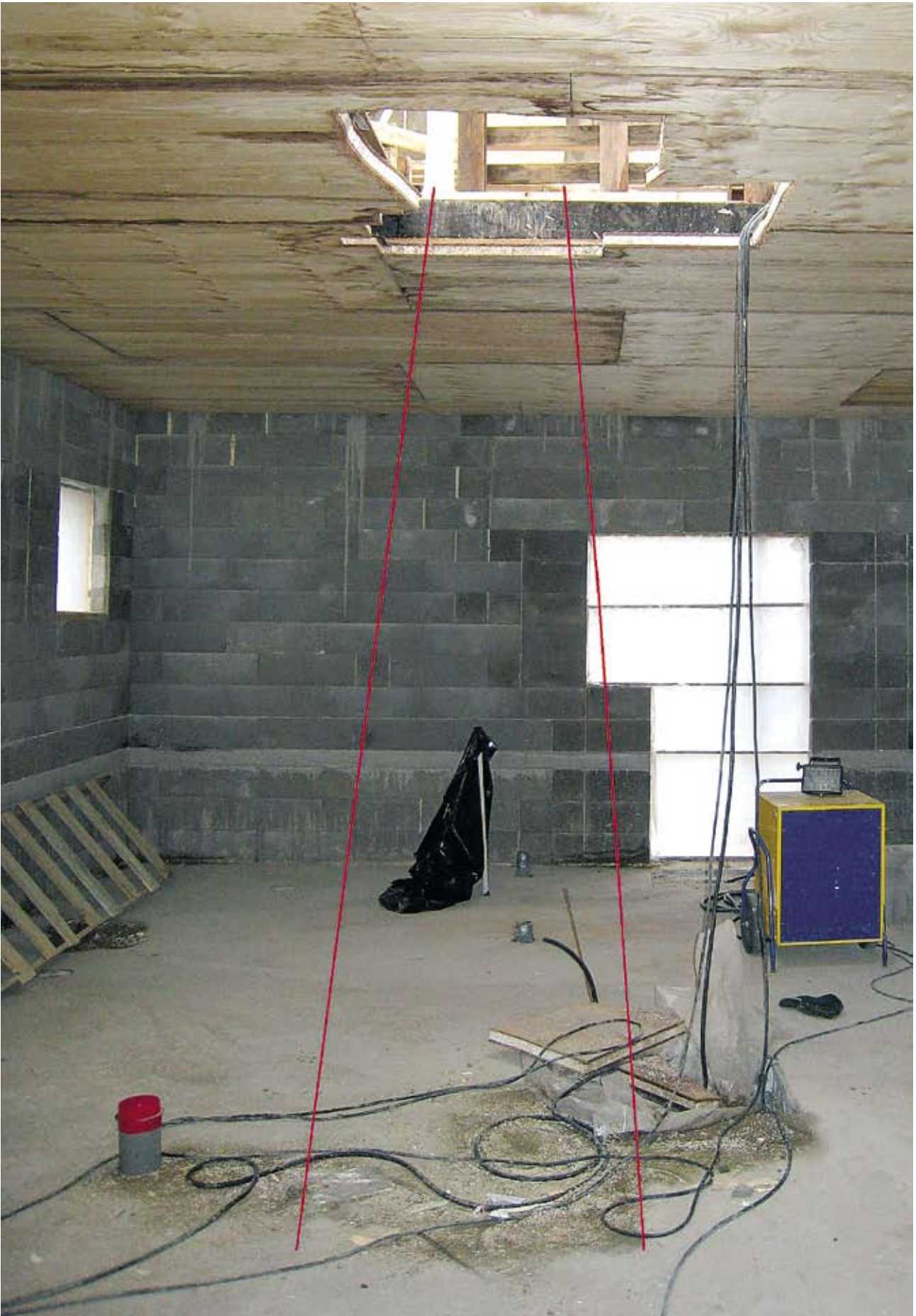
Kuva 1. Yleiskuva rakennuksen 1. kerroksesta. Punaisella havainnollistettu tikkaiden suunta.
