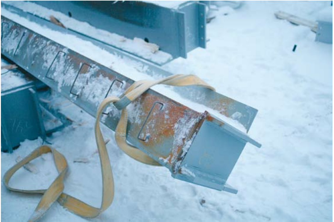
Kuva 3. Työ suunniteltiin tehtäväksi nostoliinujen avulla, joka on yleisesti käytetty ja vaikiintunut työmenetelmä elementtiasennuksissa. Kuva käytetystä sidontamenetelmästä.
