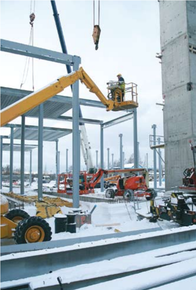
Kuva 1. NN nostettiin asennuskohteseen ns. kuukulkijaksi kutsuttavalla henkilönostimella. NN:n tehtävänä oli ohjata palkki käsin paikalleen ja kiinnittää pultit.
