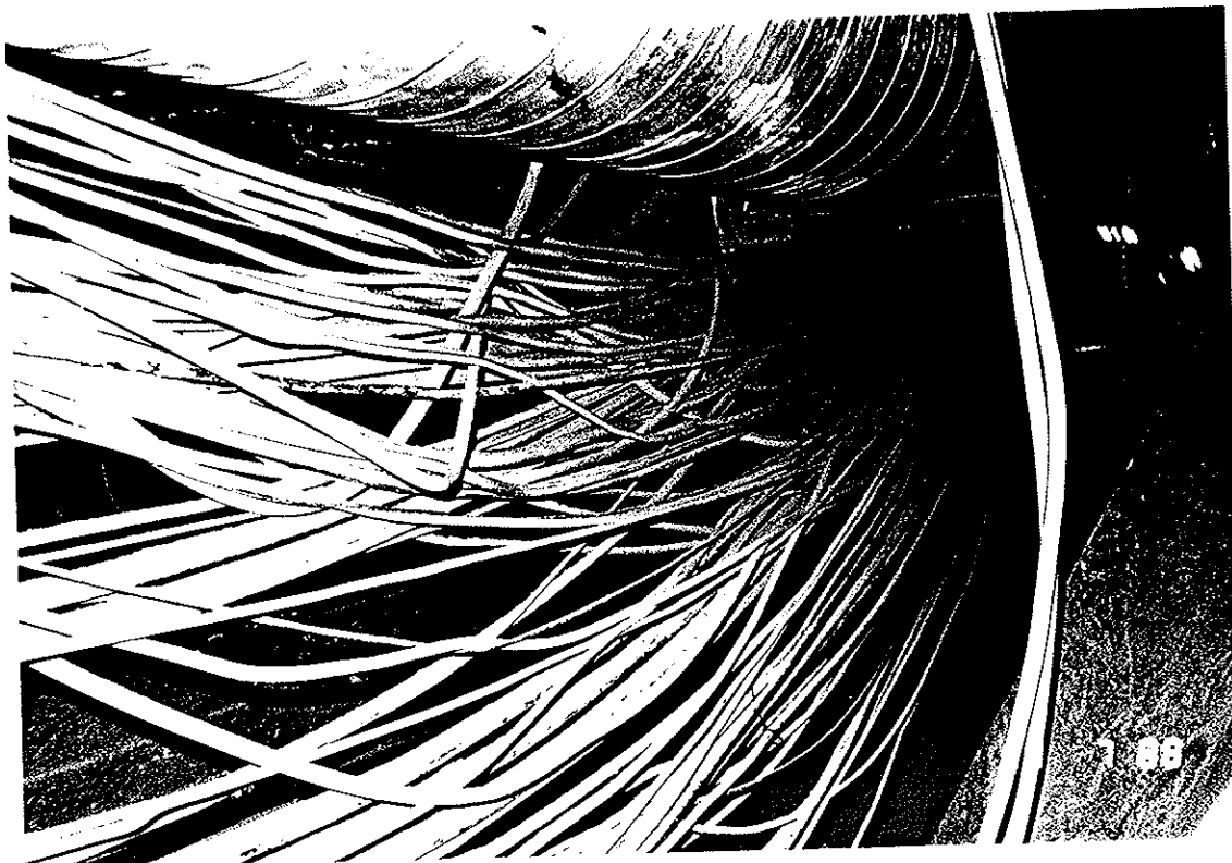
Kuva 3. Vanhasta keskuksessa tulevat johdot
