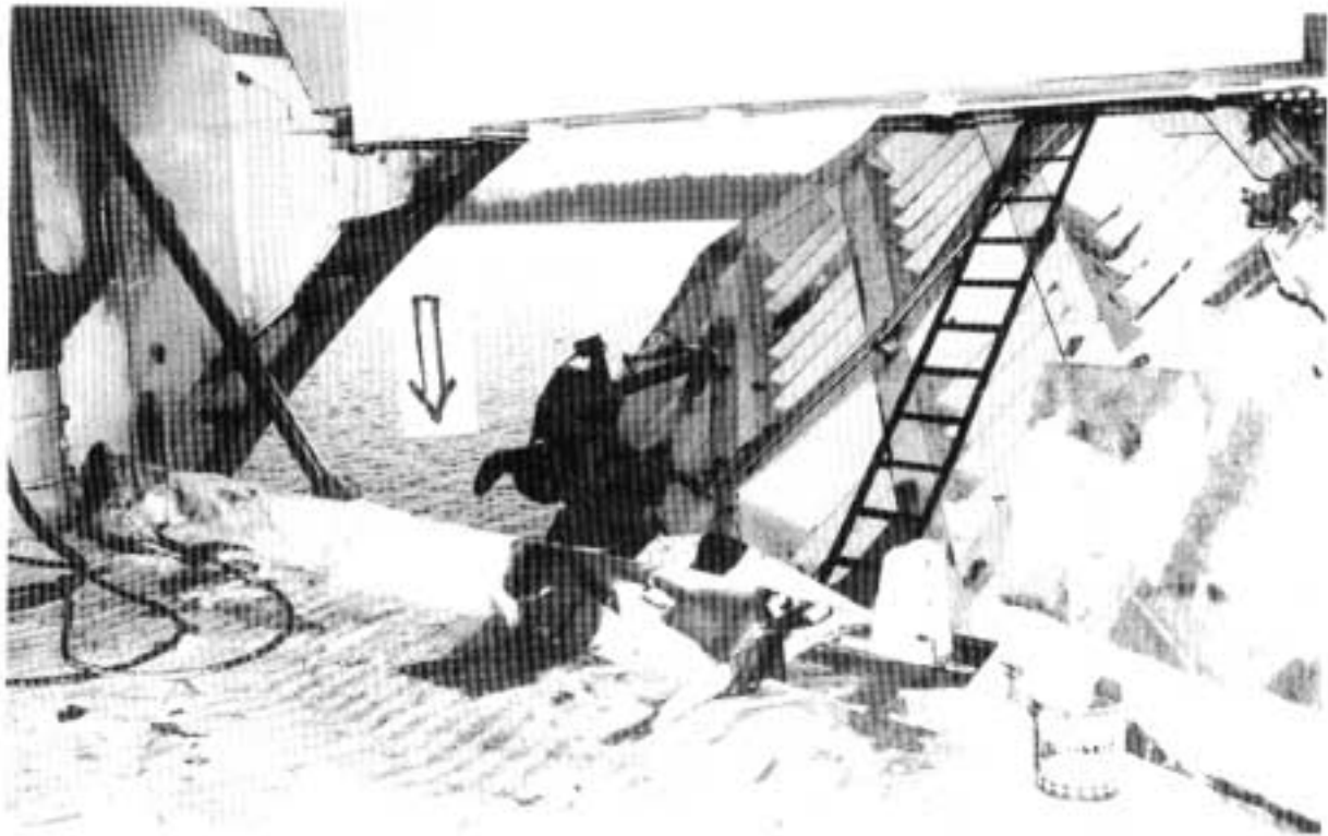
Kuva 1. Ajosillan reuna, nuoli osoittaa putoamispaikan.
