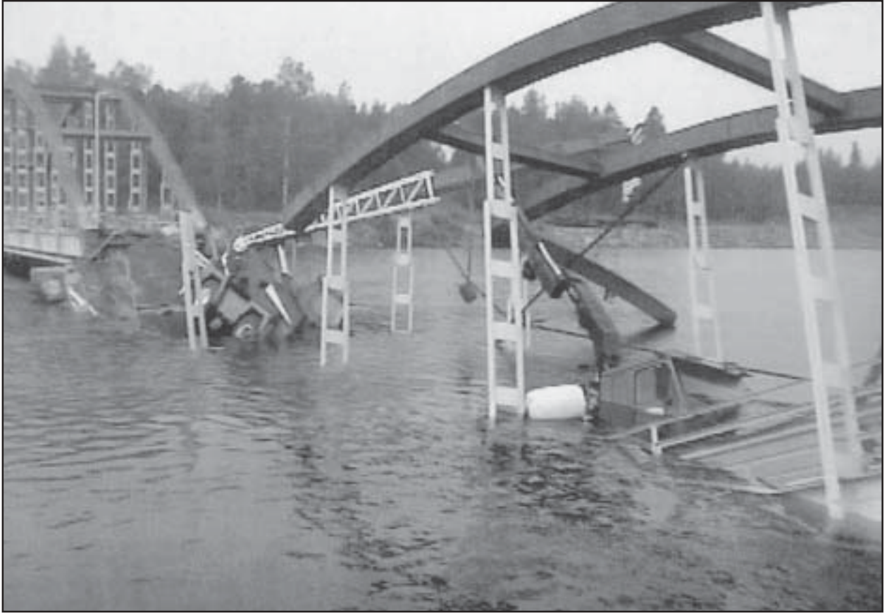
Kuva 4. Kuva sortuneesta sillasta (itäranta, alavirta).
