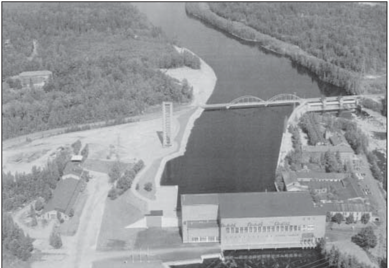
Kuva 1. Ilmakuva voimalaitoksesta ja purettavasta sillasta.
