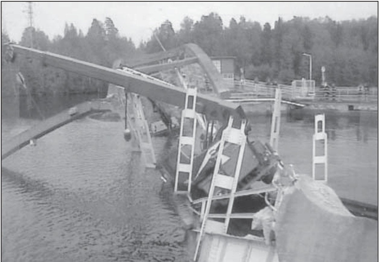
Kuva 5. Kuva sillasta sillan pituussuuntaisesti.
