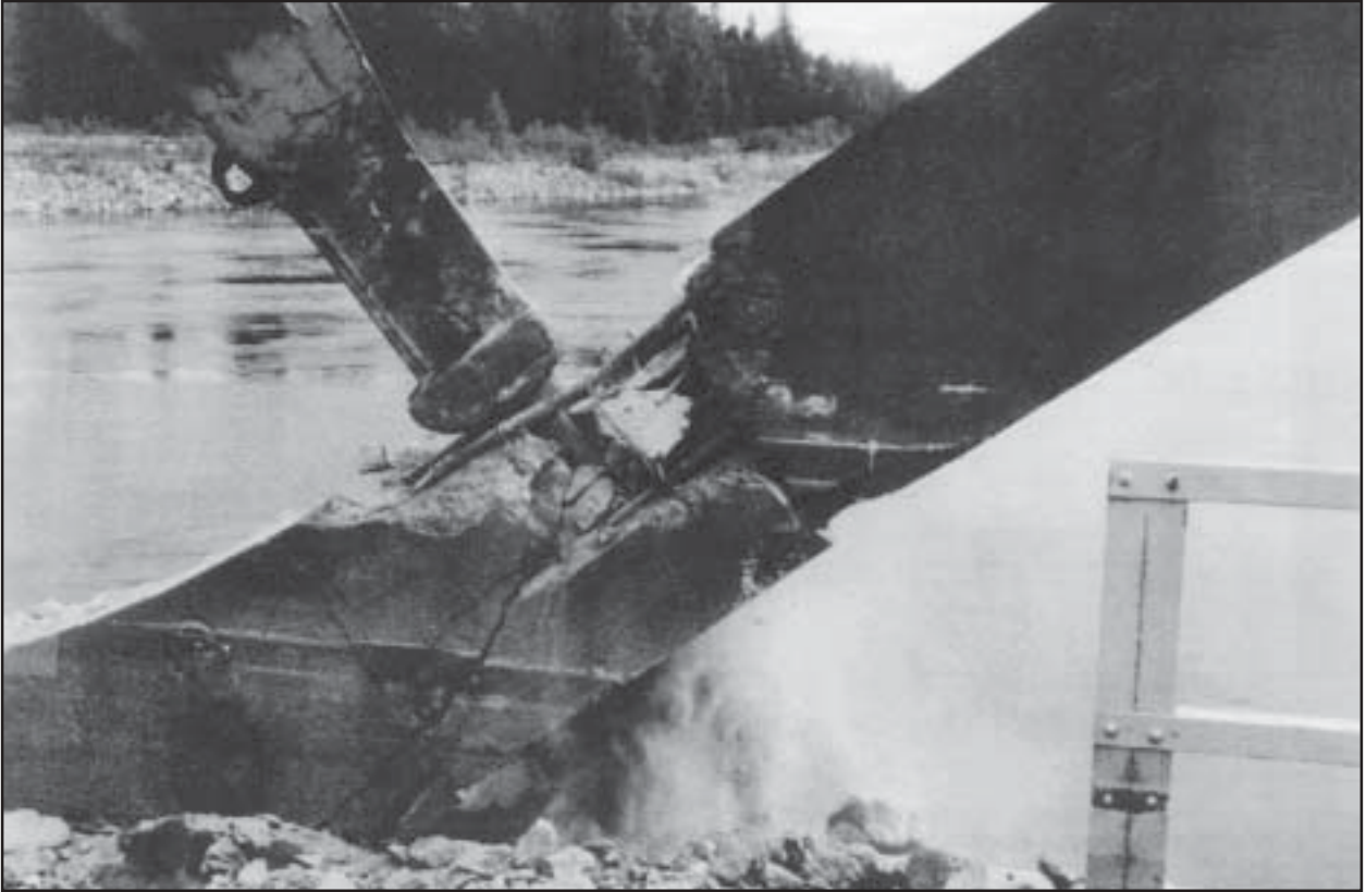
Kuva 2. Iskuvasara piikkaamassa Langer-palkkisillan betonikaarta.
