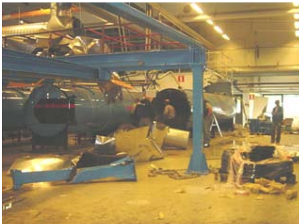
Kuva 4. Yleiskuva tuotantotilasta tapaturman jälkeen. Kammio siirtyi paikaltaan taaksepäin n. 4 metriä. Edessä vaurioitunut ja irronnut teräksinen tukipalkki, johon pääty osui.
