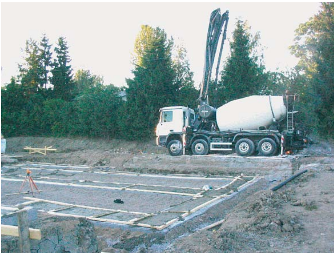
Kuva 1 Yleiskuva omakotitalon perustuksen valutyövaiheesta. 20 kV:n ajojohto kulkee kuvan yläreunassa (ei näy) puomin pään kohdalla.
