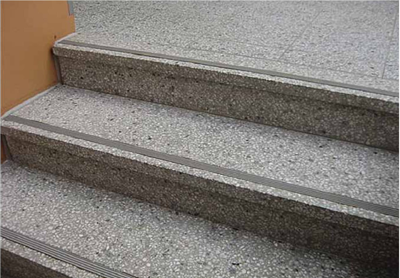
Kuva 2. Portaikko ei ollut erityisen liukas, ja askelmien etuosiin oli asennettu kumiset liukastumisen estävät listat.
