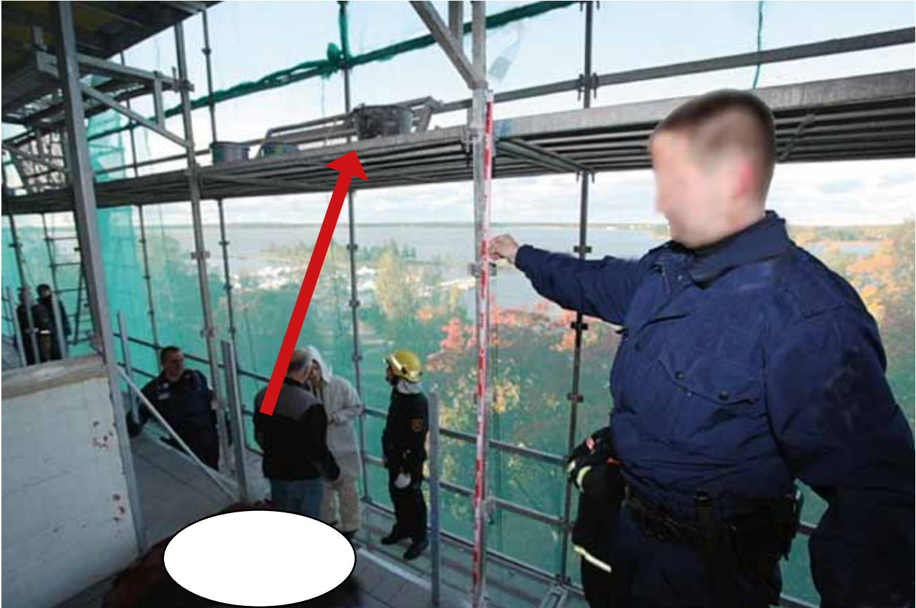
Kuva 3. Kuvan yläreunassa seitsemännen kerroksen taso, jolta NN putosi valkoisella soikiolla merkittyyn kohtaan. Viisto nuoli vasemmalla osoittaa poistettua lisäsivutelinettä. Putoamisen jälkeen NN löytyi valkoisella soikiolla merkitystä kohdasta.
