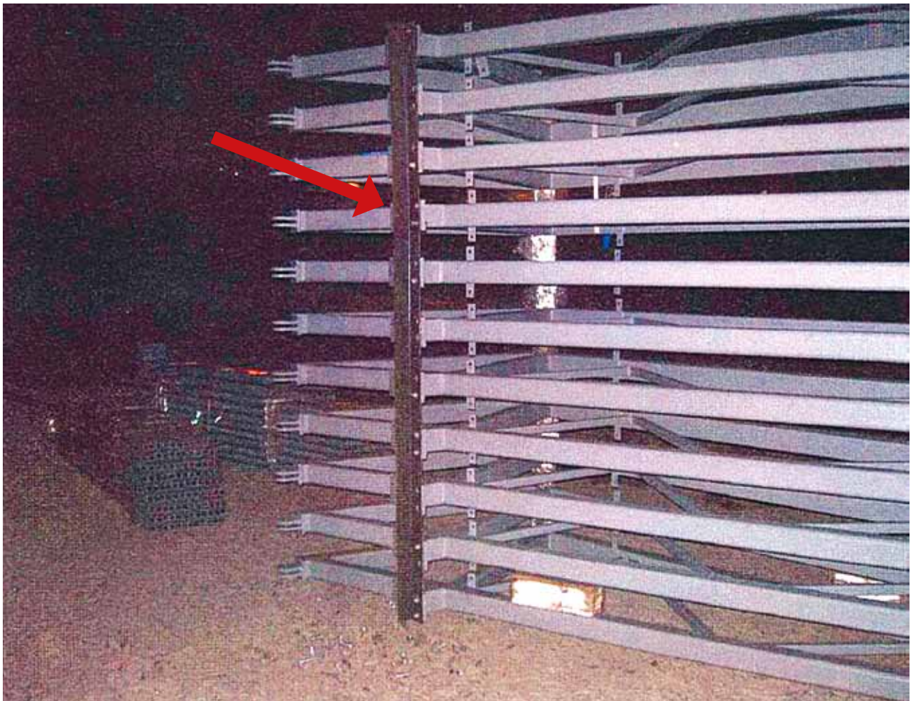
Kuva 2. Jalkaniippua tukeva kulmaraudan kiinnitystapa purkamatta jääneessä nipussa.
