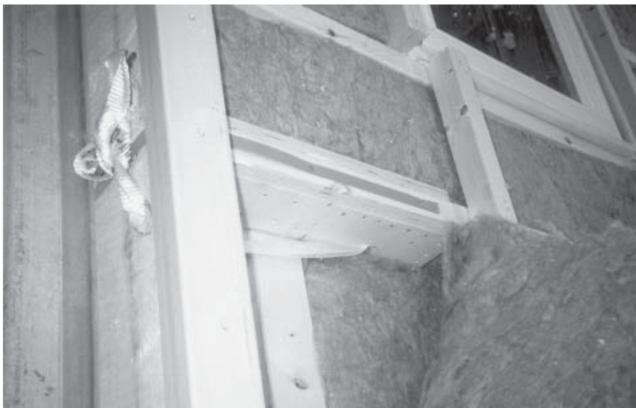
Kuva 6. Muutettu, vahvistettu kiinnitys.
