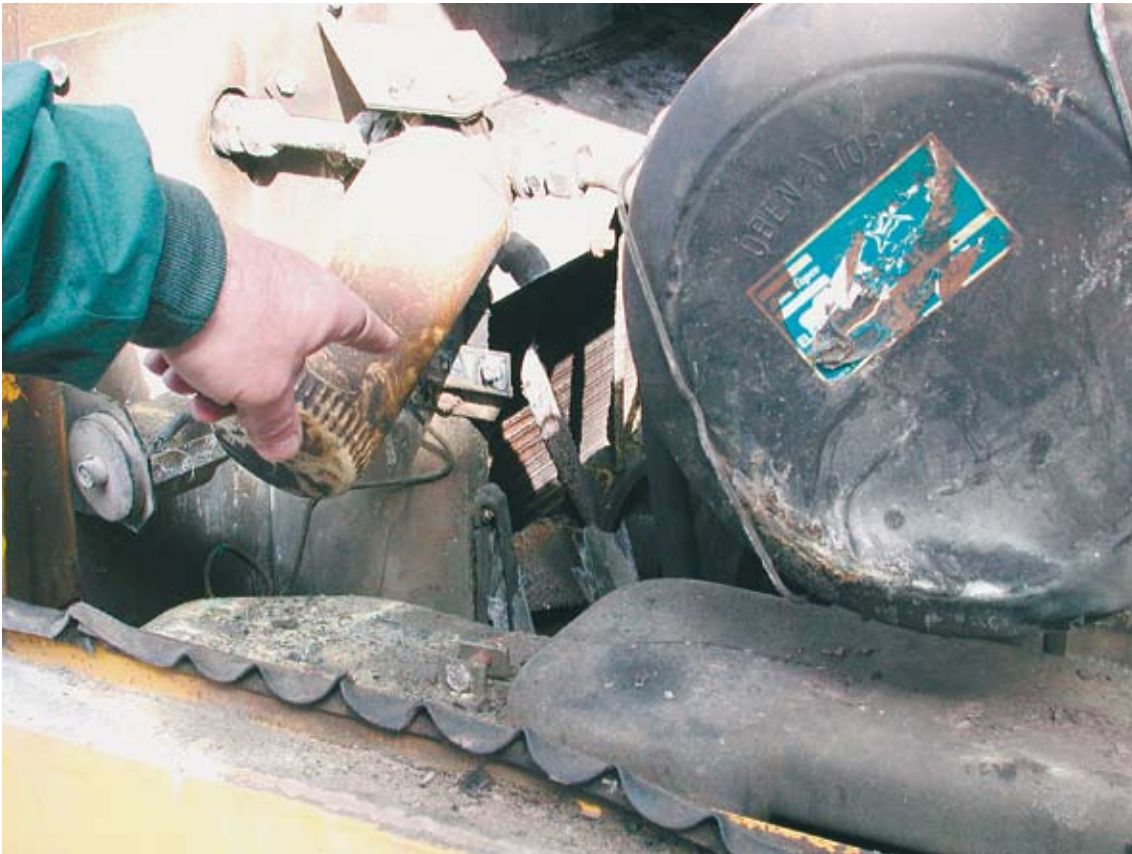
Kuva 3. Henkilö osoittaa sormellaan kohtaa, jossa todennäköisesti tapahtui tulipalon aiheuttanut oikosulku.
