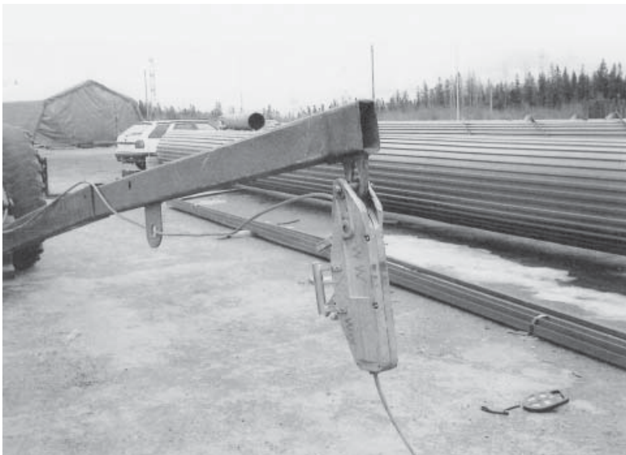
Kuva 3. Työssä käytetyn puomin pää sekä siihen kiinnitetty vaijeritalja.
