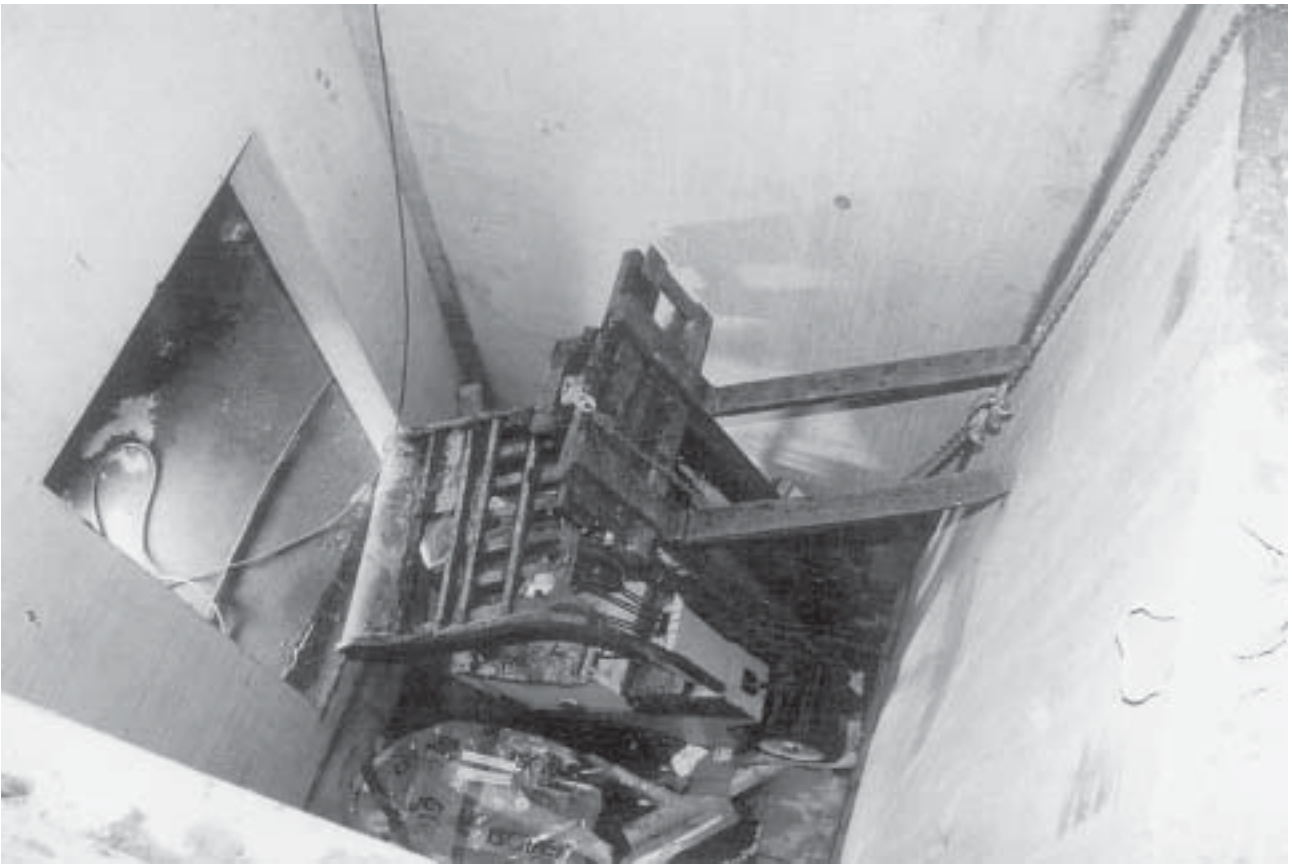
Kuva 3. Trukki kuilun pohjalla.
