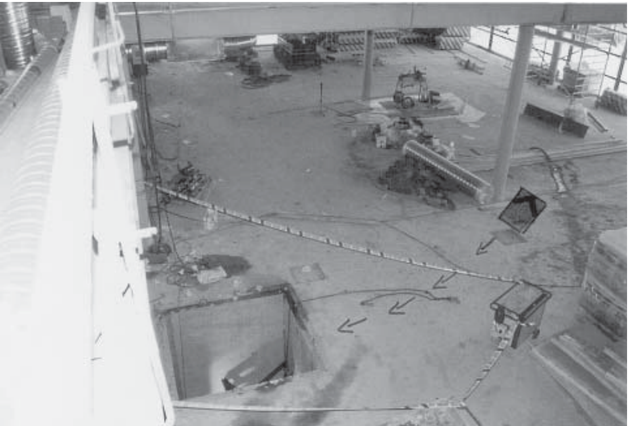
Kuva 2. Trukki peruutti hissikuiluun.
