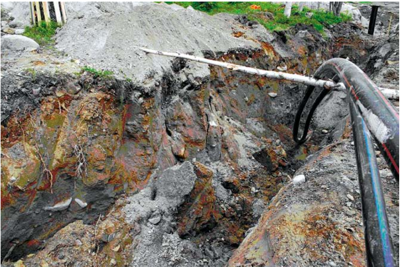
Kuva 3. Kuvassa näkyy perusmaan kerrosten vaihtelu ja murtunut luiskan reuna.
