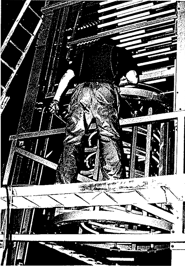
Kuva 1. Kaapelihylly, häkkirakenne, oikean kyynärpään korkeudella asennettava jäykiste (lavastettu)
