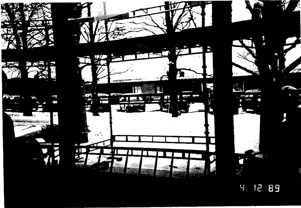
Kuva 1. Aulan sisääntulokohta, josta siirrettävä Haki-teline kaatui pylväiden välistä. Telineitä ei ollut tapaturman sattuessa.
