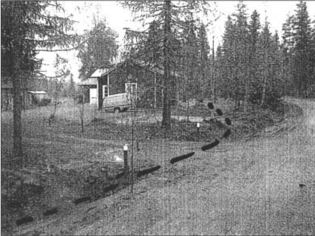
Kuva 1. Kuvassa NN:n kiinteistö ja kiinteistölle johtava liittymä. Kuvassa nähtävissä täytettyä vesijohtokaivantoa (katkoviiva). Kuvan vasemmassa alareunassa tapahtumapaikka.
