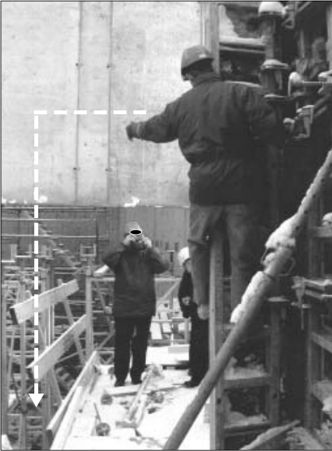
Kuva 3. NN oli noussut viereisen, jo paikoilleen asennetun muotin tukipalkkeja pitkin noin metrin korkeuteen (lavastettu tilanne). Katkoviiva kuvaa NN:n liikettä tapahtuman aikana.
