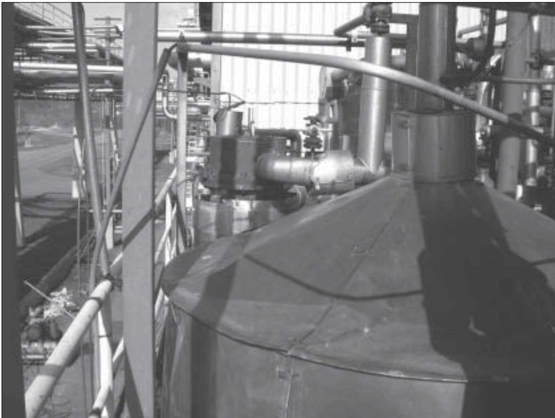
Kuva 1. Lähikuva kartiomaisen reaktorin kannesta.
