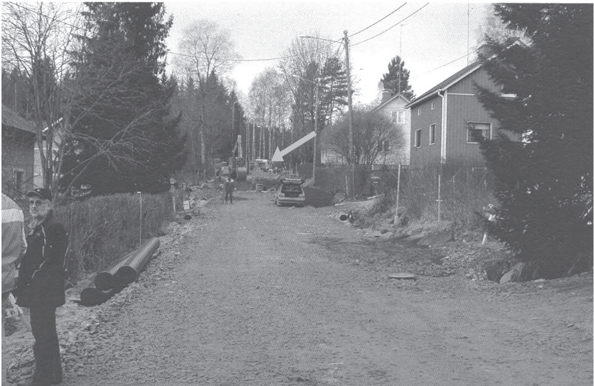
Kuva 2. Tietyömaa 1,5 kk tapaturman jälkeen, jolloin peruskorjaustyö oli vielä kesken. Tapaturma sattui oikealla olevan talon kohdalla. Tien päässä (nuoli) kaivinkoneen takana näkyy taukotupa.
