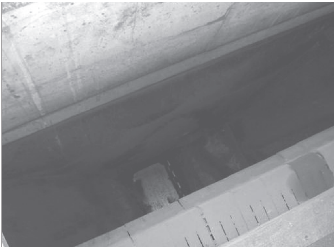
Kuva 2. Tuhkasuppilo ylhäältä päin kuvattuna.
